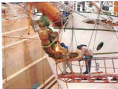
El personal de soldadores iniciando al acayeo de las costuras de soldadura
