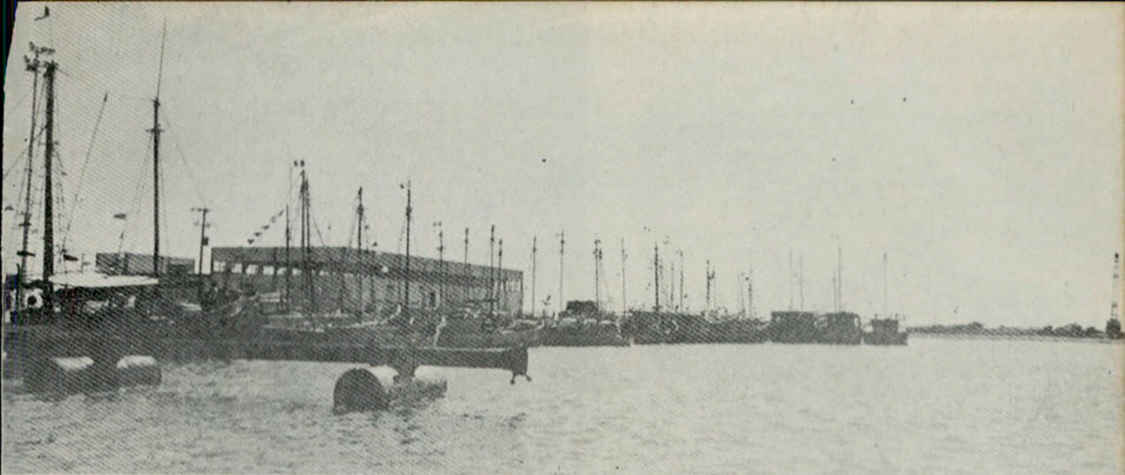
Instalaciones en el puerto de Yukalpetén, Yuc.
