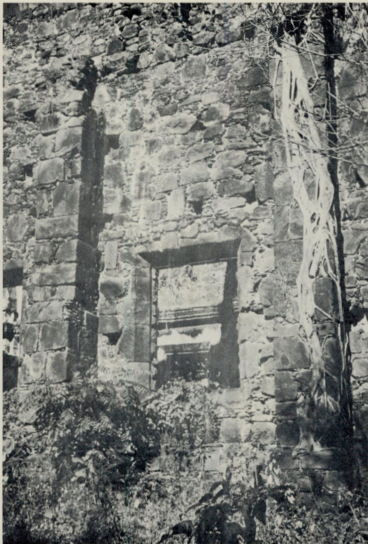
Fachada lateral de la iglesia en San Blas, estado actual
