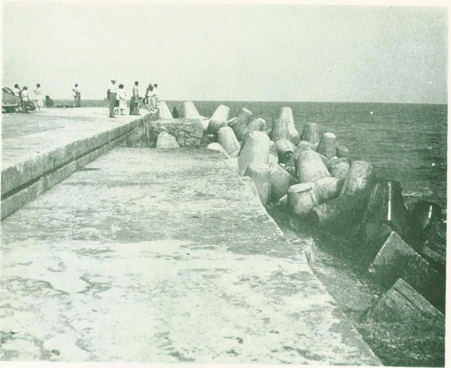
Reconstrucción de la escollera norte del puerto de Tampico.
