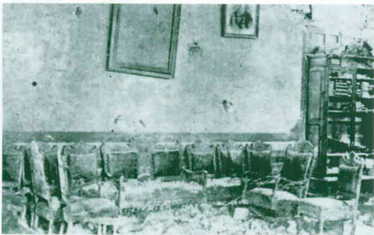
Interior de la Escuela Naval Así quedaron las oficinas del Comodoro Manuel Azueta tras los efectos del bombardeo del Crucero Chester.
