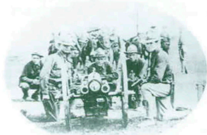
Parte de una batería norteamericana situada delante del Edificio de la Dirección General de Faros, para defender esa posición
