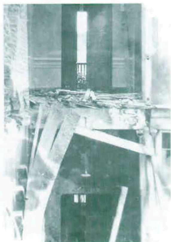
Casi en ruinas quedó la dirección de la Escuela Naval y muchos salones del frente.
