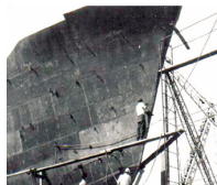
Aspectos de las distintas fases de construcción del buque México .
