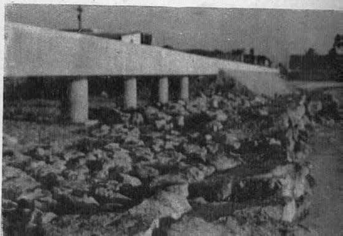
Arranque del muelle de pesca en el Puerto de Progreso, Yucatán.
