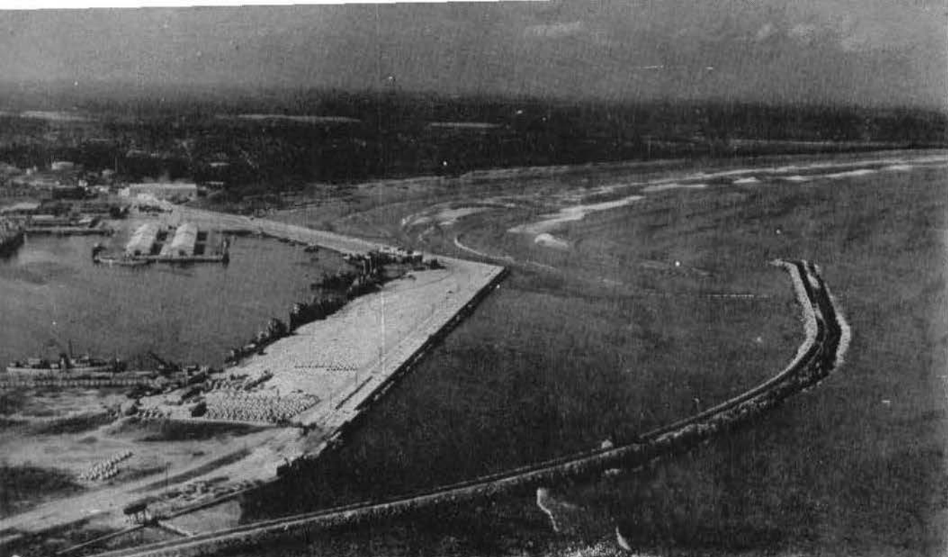
Rompeolas de protección al Muro del noroeste, en el Puerto de Veracruz, Ver.
