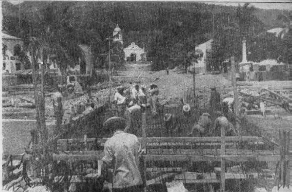
Construcción del muelle en Puerto Balleto en el Penal de las Islas Marías, Estado de Nayarit.
