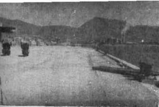
Vista de la Banda Este del Muelle Patio del Moderno Puerto de Guaymas, en el Estado de Sonora.
