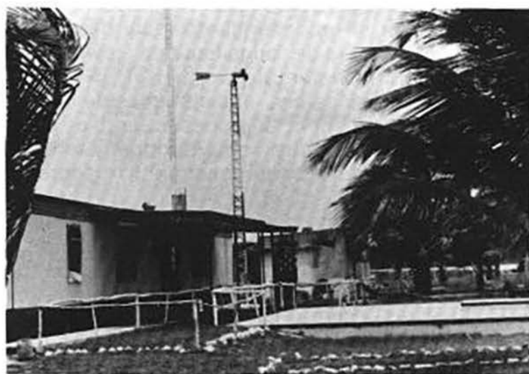
Caseta de radio operada con generador de viento.
