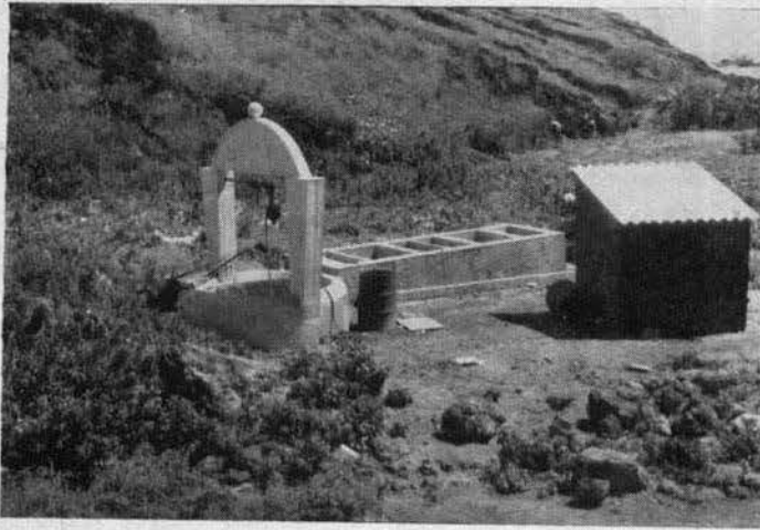
Agua potable. Pozo, lavaderos y hortaliza.
