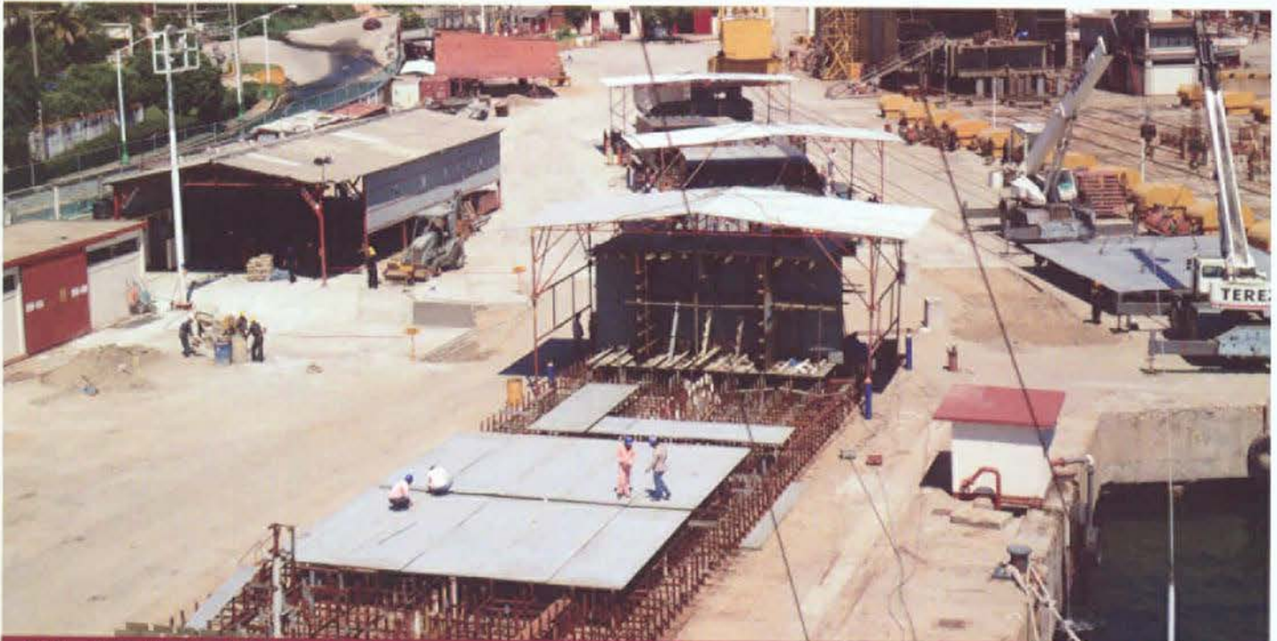
En la cama de ensamble durante tres semanas se acondicionan los bloques que posteriormente pasan a la cama de erección.
