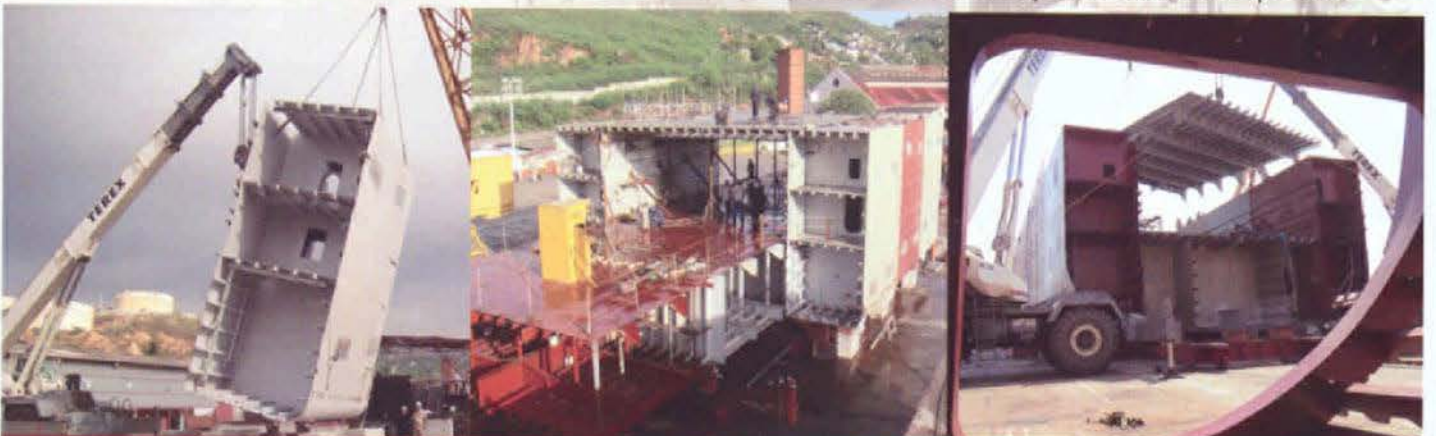
En las etapas de ensamble y erección se unieron los 72 bloques para conformar al Buque de Apoyo Logístico.
