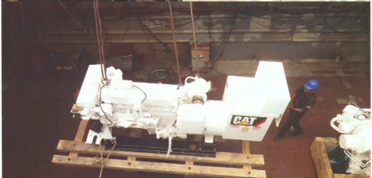
En la etapa de alistamiento se instalarán todos los equipos, cables, tuberías, entre otros, que integran cada uno de los sistemas del buque.
