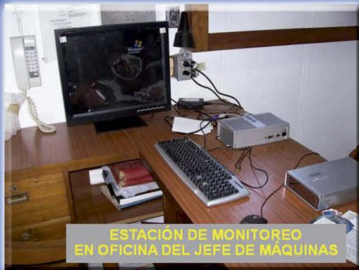
La Estación de Monitoreo se localiza en la Oficina del Jefe de Máquinas. El Proyecto DISICOM puede ejecutar acciones de autodiagnóstico, imprime lecturas de las variables de operación y registra hechos relevantes.
