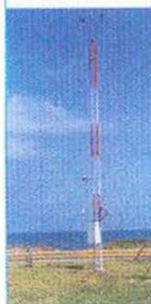
Estaciones automáticas con transmisión satelital, de la Red Meteorológica Marítima de la Secretaría de Marina-Armada de México.
