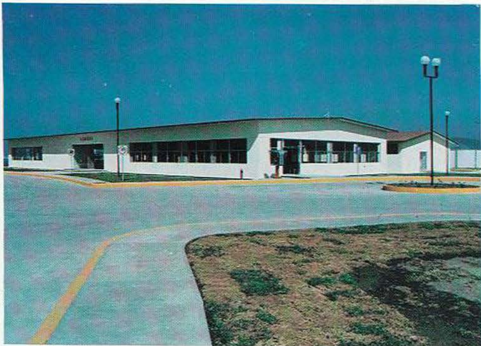
La unidad de cocina-comedor tiene la capacidad para brindar servicio a 720 comensales.
