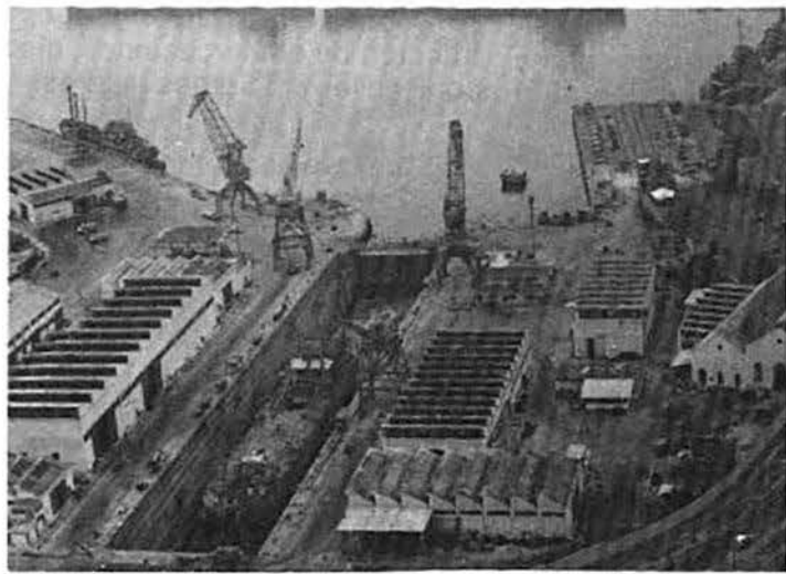
Vista parcial del Astillero de Marina No. 20, en Salina Cruz, Oax.
