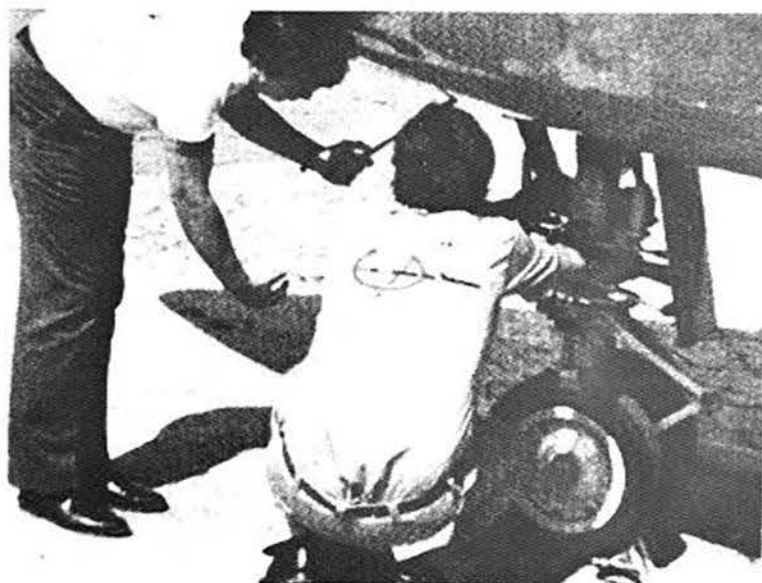
Chequeo general de todos los sistemas del avión, importante operación para evitar anomalías en el vuelo. En la gráfica revisión del tren de aterrizaje.
