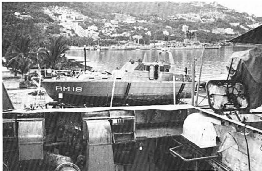
Patrulla tipo Olmeca construida en el Astillero No. 18, varada en las instalaciones del mismo para su reparación.
