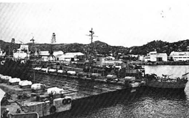
Astillero de Salina Cruz, Oax. En primer término el sincroelevador, al fondo los talleres de fundición y electricidad.
