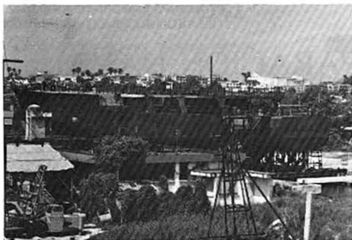
Construcción de uno de los buques de la clase Holzinger en las instalaciones del Astillero No. 1, en Tampico, Tamps.
