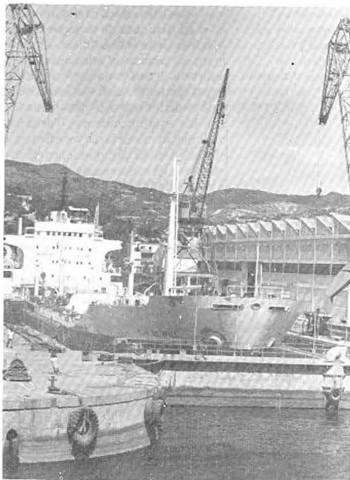
Dique flotante empleado para las reparaciones menores de los buques.
