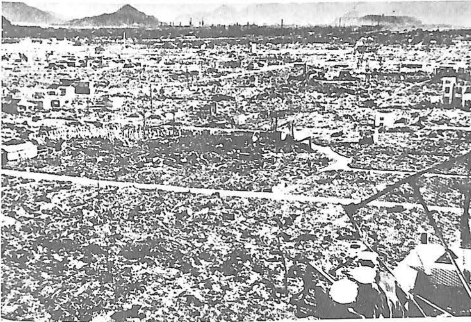
Vista general de la ciudad japonesa después de haberse recogido los escombros de las principales calles.
