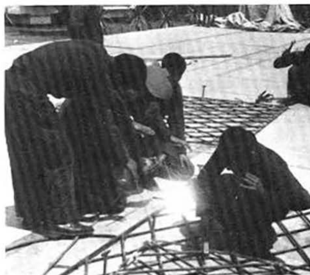
Durante la III Semana de Solidaridad Personal de la Secretaría de Marina-Armada de México, proporcionó apoyo con mano de obra en trabajos de herrería, carpintería, fontanería, albañilería y pintura.
