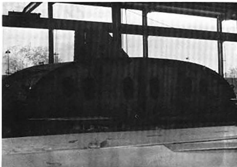
*Instalación del forro y talón de quilla de un bloque (etapa 30, ensamble).*
