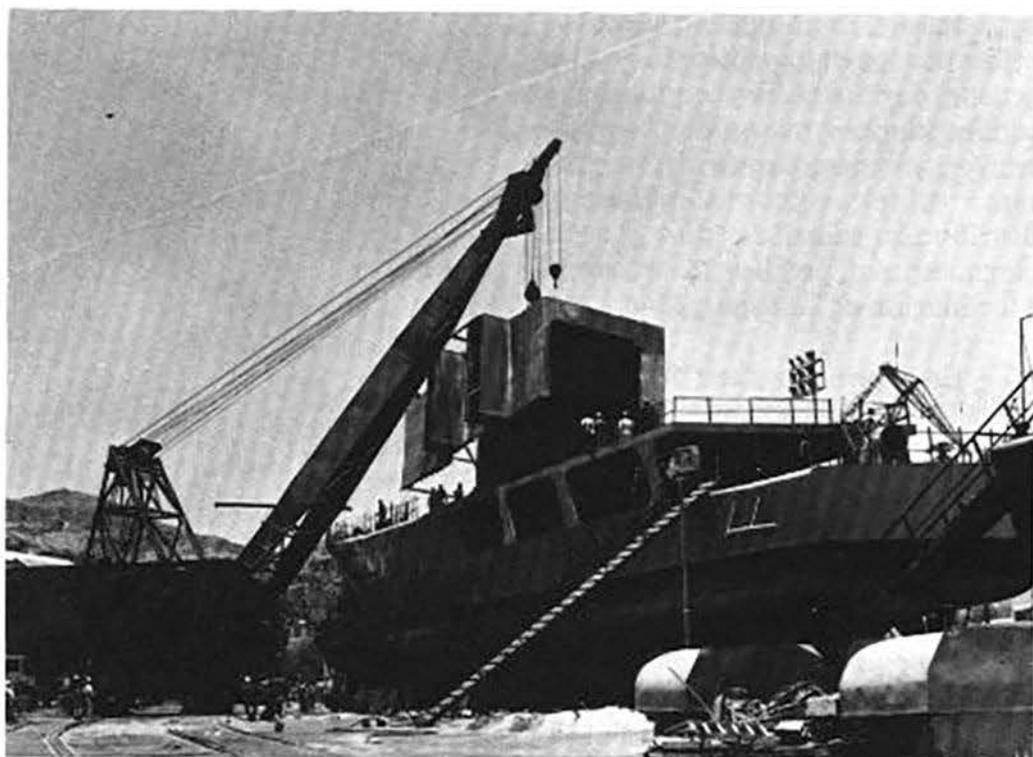
Una de las características del buque clase Holzinger es su capacidad de portar un helicóptero. Aquí se muestra el momento en que se monta el hangar.
