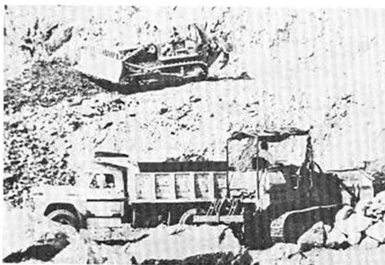
Este es parte del equipo pesado que se utiliza en los trabajos de construcción de la gran obra que se realiza en Topolobampo.
