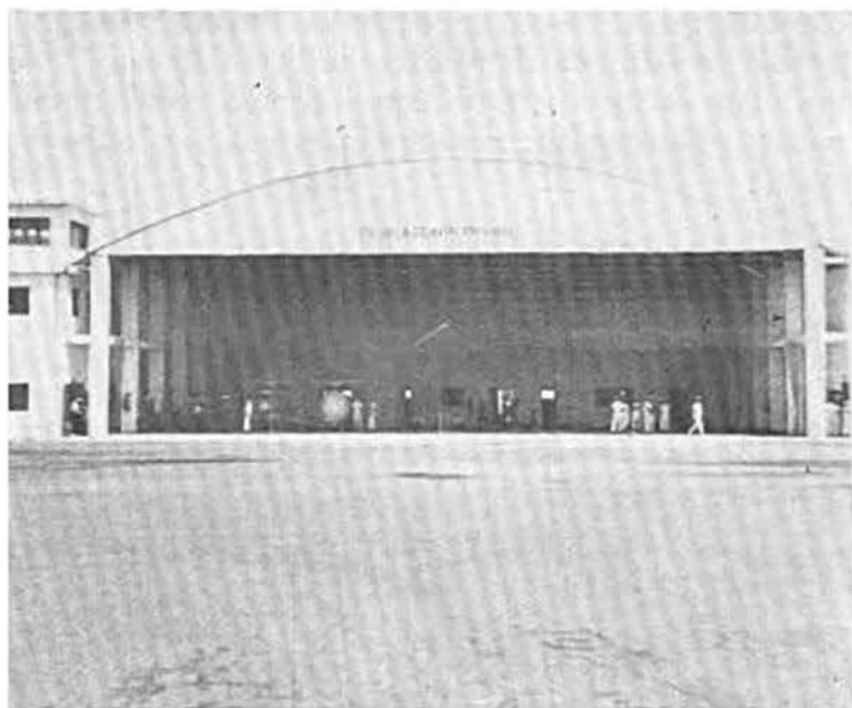
Escuela de Aviación Naval. Ubicada en las instalaciones que la Armada de México tiene destacadas en Las Bajadas, Ver.
