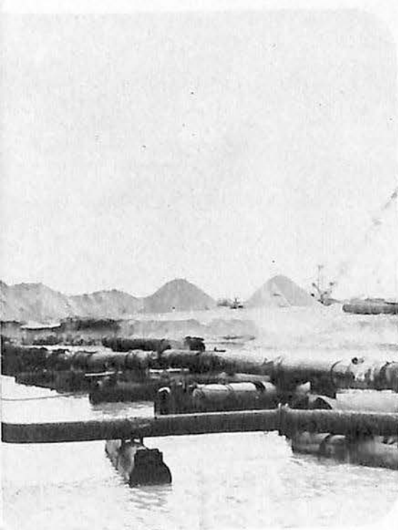
Líneas de descarga de las dragas Tampico y Progreso.
