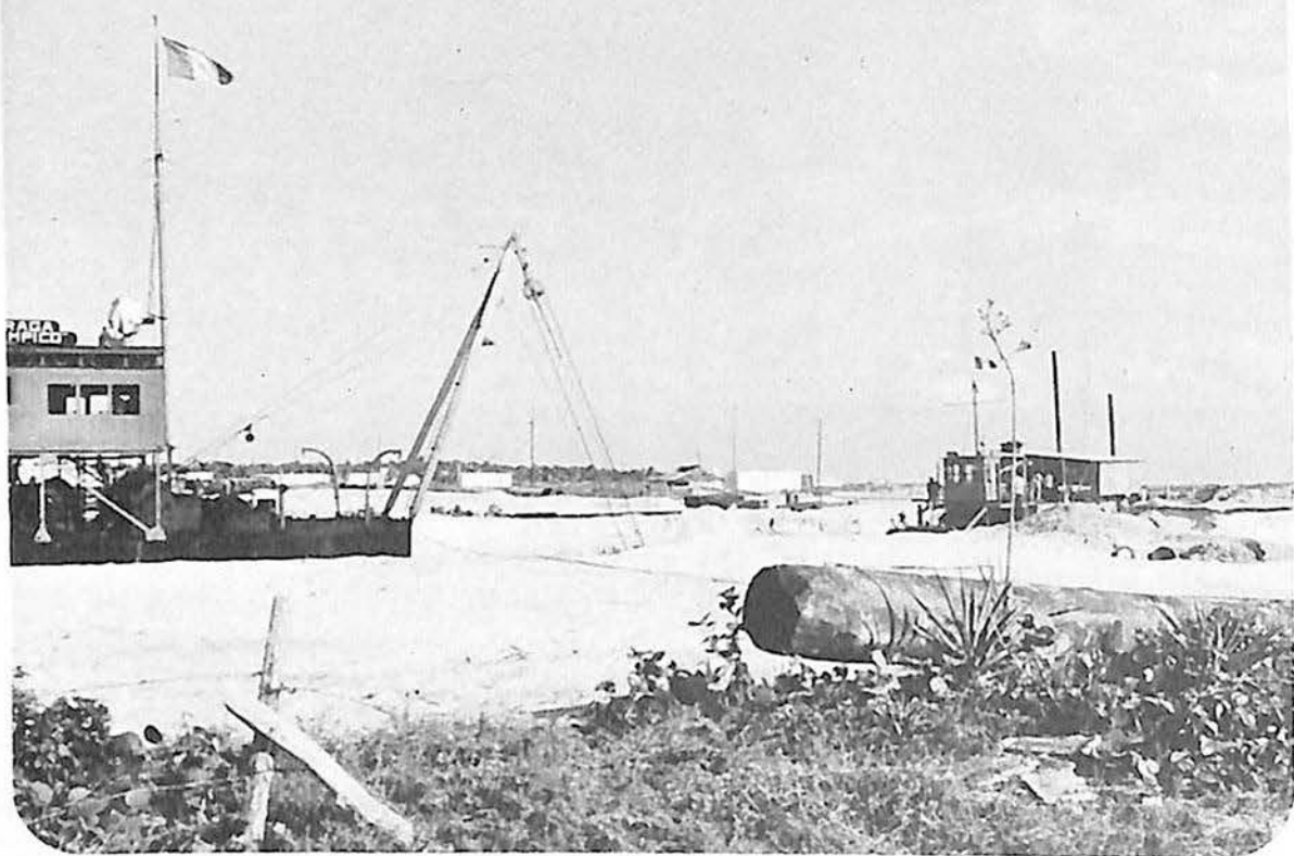
Dragado dentro del corte antes de llegar a la carretera Progreso-Chelem.
