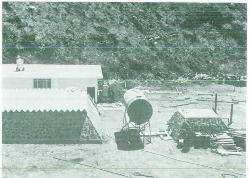
Obras de infraestructura para la planta desaladora en la Isla Socorro.
