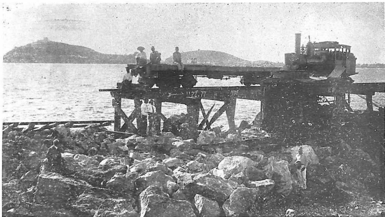
Lámina 17.—Muro del Este durante su construcción.
