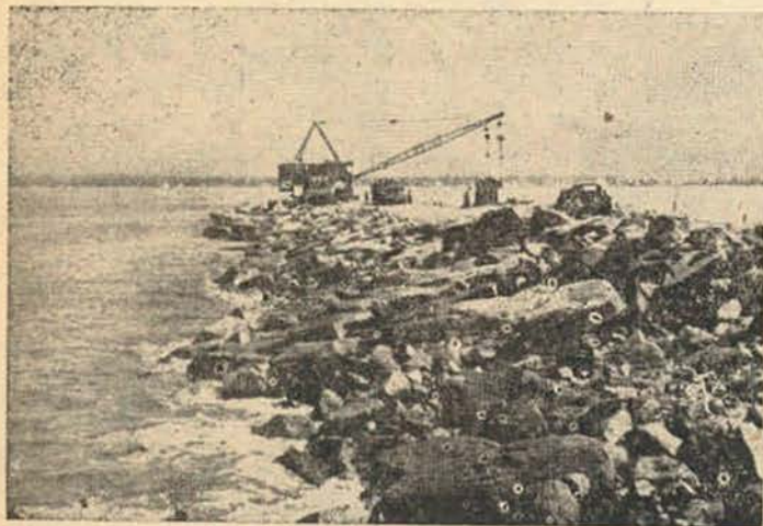
Rompeolas.—Talud del lado del mar de la prolongación del rompeolas.
