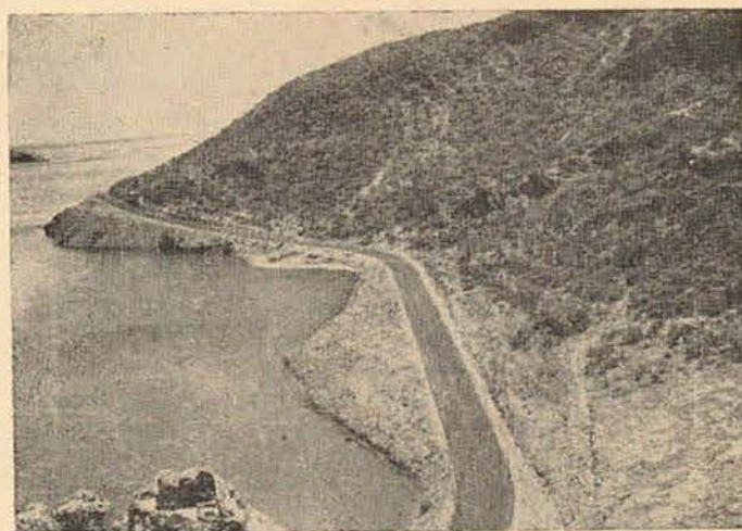
Dique entre Isla de la Azada y Cerro del Crestón.
