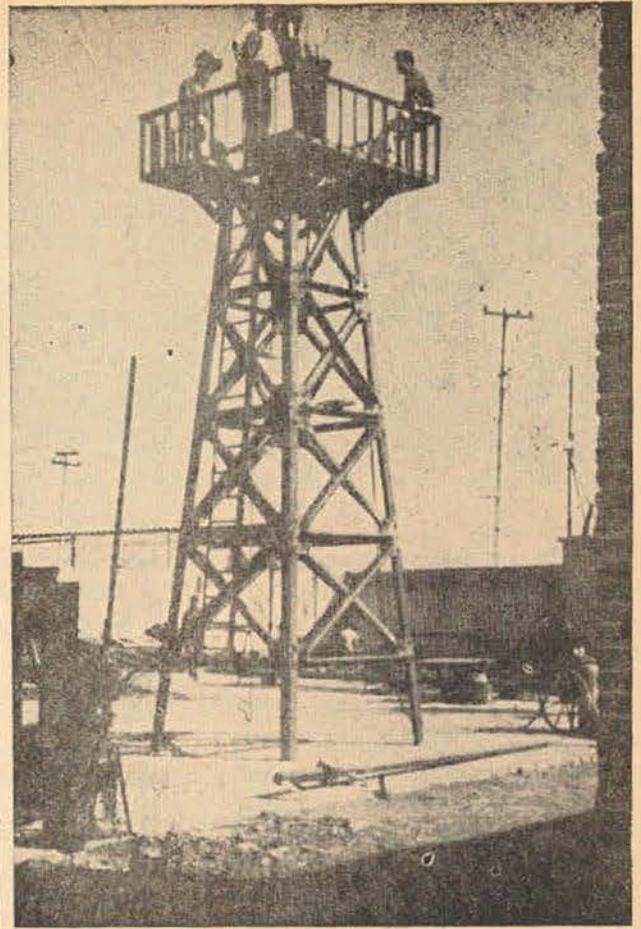
Torre preconstruída en acero galvanizado para el Faro de la Corbeteña
