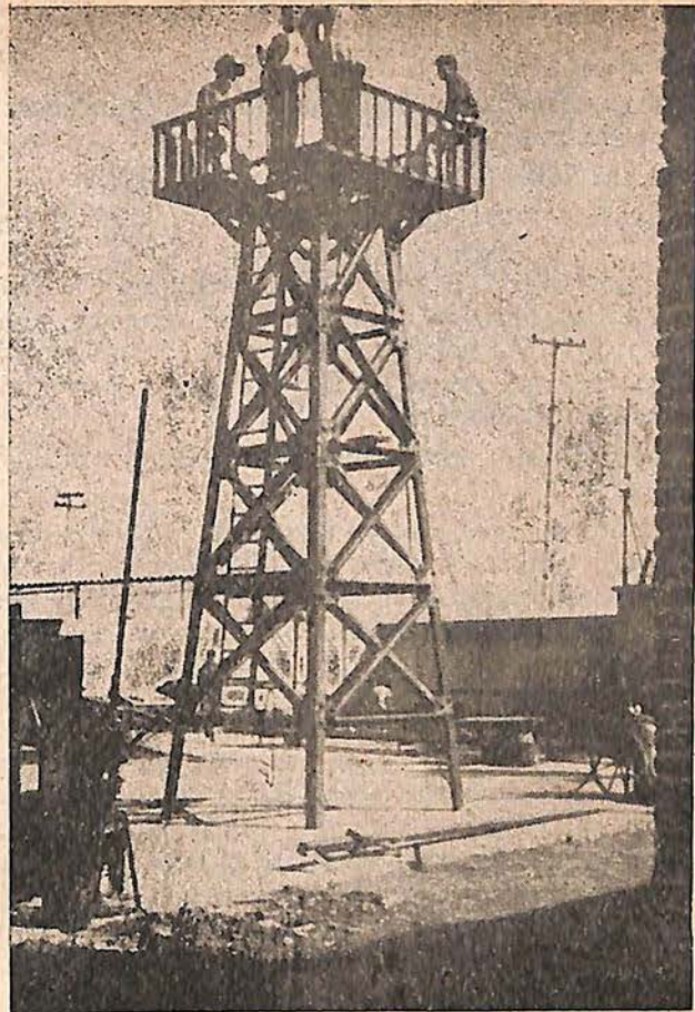
Torre preconstruída en acero galvanizado para el Faro de la Corbateña
