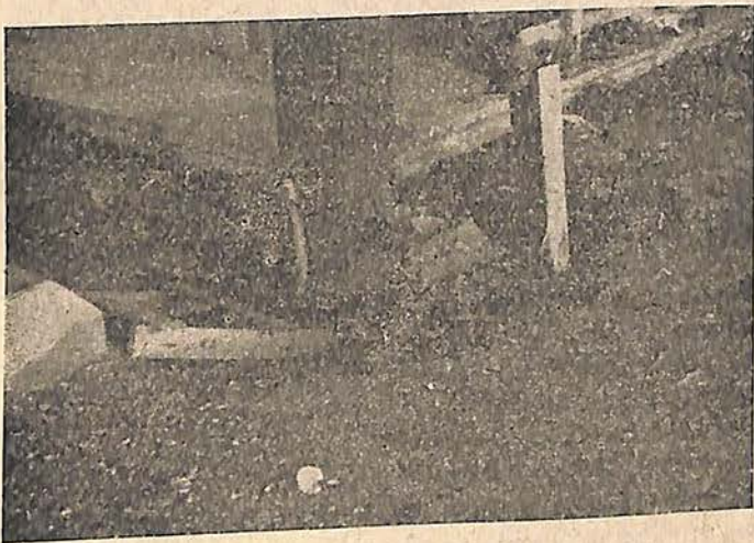
Peligrosamente se hundieron las columnas de Acero del cobertizo del Astillero de Marina.
