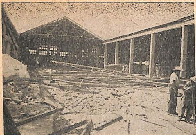
Bodegas de Puertos Libres en Coatzacoalcos, Ver., destruidas por el terremoto.
