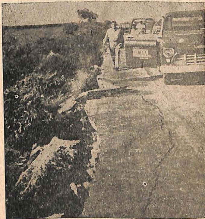
Peligrosas grietas en las carreteras dejó el terremoto.
