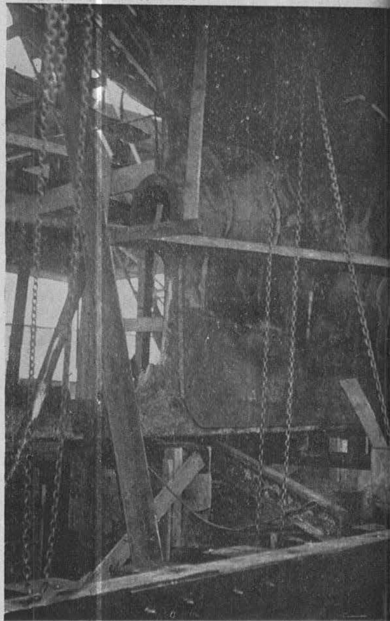
Interesante fotografía de la popa del buque "México" durante su construcción. Atención del Sr. José Asperó del Castillo.
