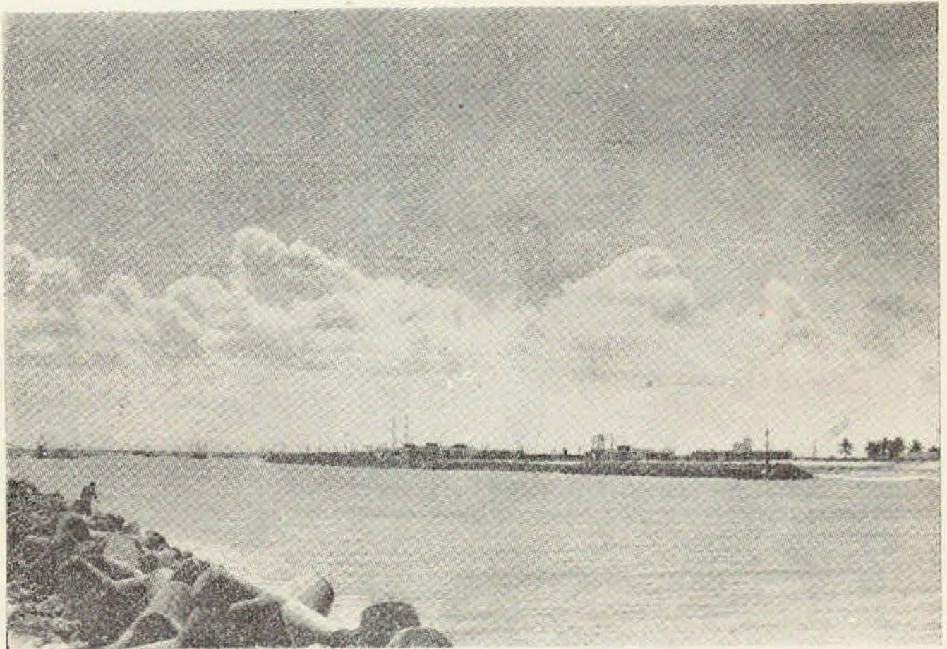
El canal de acceso entre las escolleras. Observe la amplitud de la bocana, y la completa protección con tetrapodos de las escolleras.
