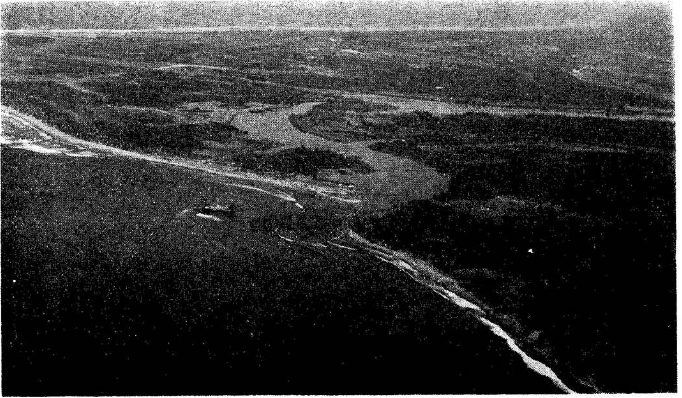
Vista aérea del lugar donde se construye el nuevo puerto Lázaro Cárdenas.
