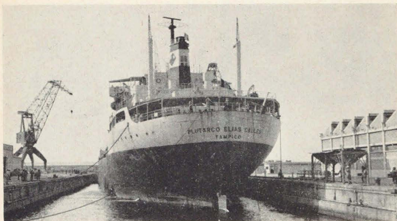
Del 1º de septiembre de 1970 al 31 de agosto de 1971, fueron reparados 116 buques en el Dique de Salina Cruz
