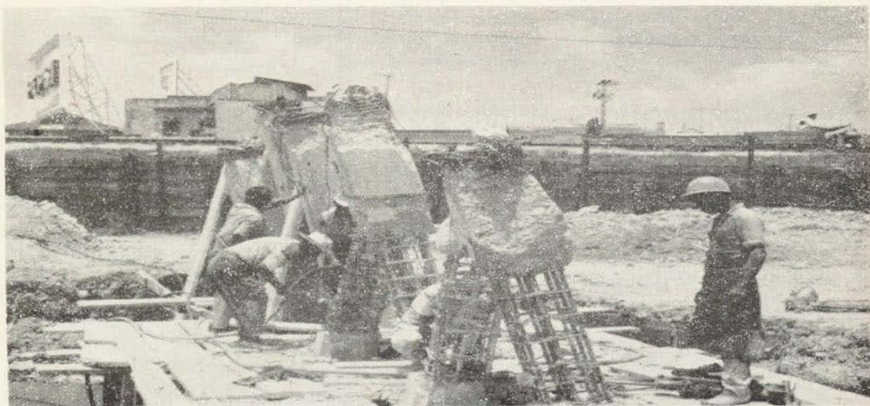
En Tampico se construye un puente sobre el canal de la Puntilla, que permitirá una mejor comunicación de la zona marítima-terrestre y beneficiará a la población
