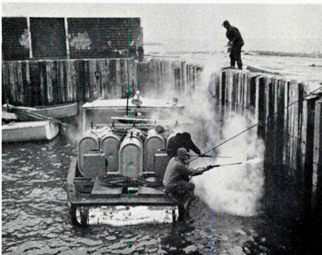
Fig. 30. Limpieza a vapor en una dársena de Arichat Harbour.
