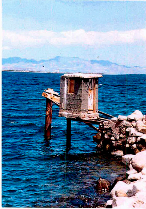
Mareógrafo analógico con registro digital en papel perforado (Bahía de Los Angeles, Baja California)
