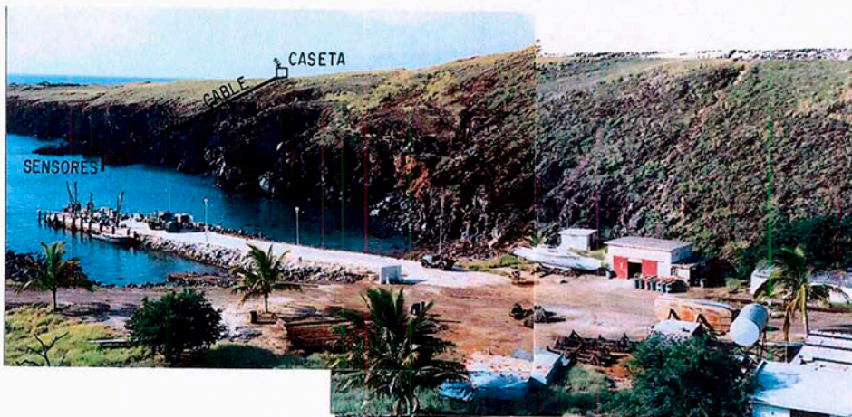
BAHÍA VARGAS LOZANO, ISLA SOCORRO Rev. Dic. 1991. SE INDICAN, EL LUGAR EN DONDE SE INSTALARA LA CASETA DEL MAREÓGRAFO Y EL LUGAR EN DONDE SE INSTALARAN LOS SENSORES DE LA ESTACION.
