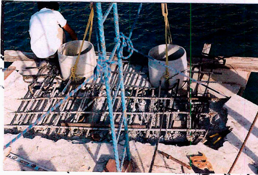
ARMADO DE LA LOSA CON VAPILLA DE 3/4" AMARRADA AL ARMADO DEL "DUQUE DE ALBA". SE INSTALAN BARRAS DE ACERO INOXIDABLE QUE ATRAVIESAN LOS TUBOS DE ASBESTO PARA EVITAR DESPLAZAMIENTOS VERTICALES DE LOS MISMOS.
