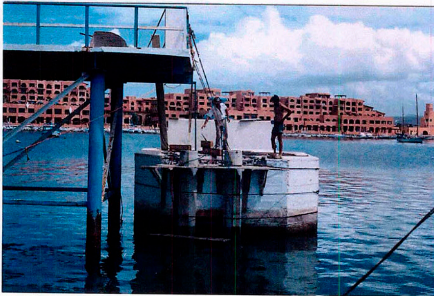
EN EL BORDE DE LA LOSA DE 20 CM. DE ESPESOR SE CONSTRUYO UNA CASETA DE BLOQUES CON CAPELLLOS ENCAJADOS.
