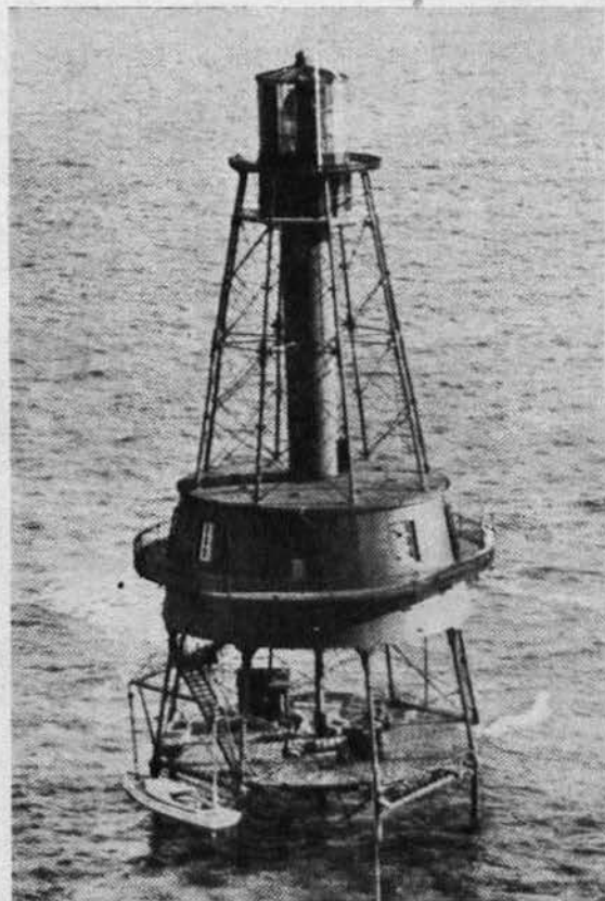
Faro en la Estructura Metálica situado en el mar.
