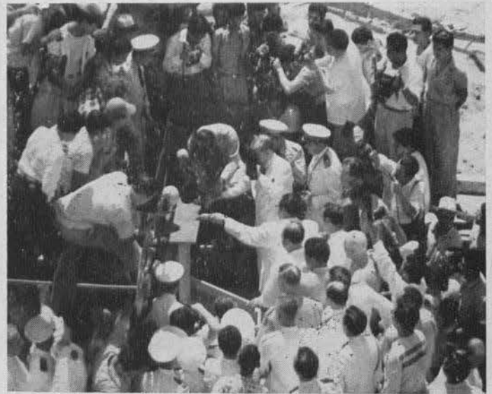
Momento en que el Sr. Presidente don Adolfo Ruiz Cortines, pone los primeros puntos de soldadura en la construcción del Barco pesado, primero que se construye en los Astilleros Mexicanos.
