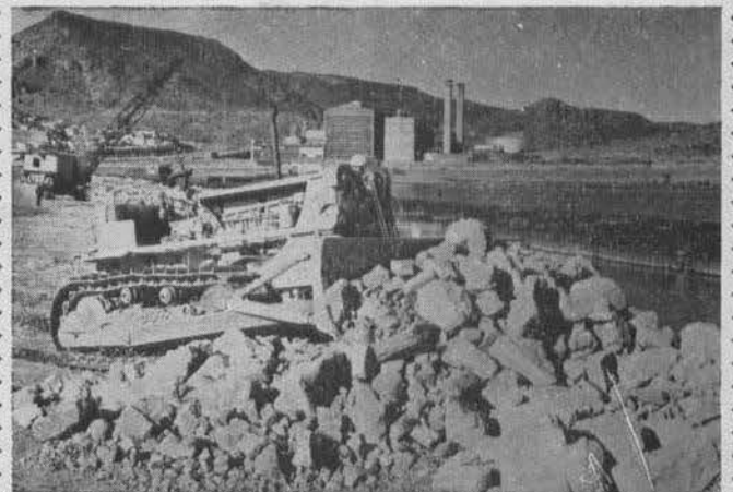
Movimiento de material para el relleno en la construcción de un atracadero con paredes formadas por un sistema celular de tablas metálicas y obras conexas de recubrimiento en el Puerto de Guaymas, Son.
