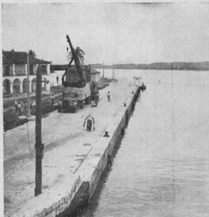
Vista del Nuevo Malecón en proceso de construcción en Alvarado, Ver.
