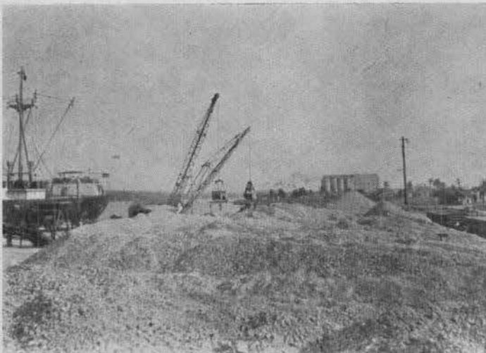
Tierras minerales descargadas en el primer tramo del Muelle de Metales y Minerales, construído por el Gremio Unido de Alijadores, SCRL., por cuenta de la Sría. de Marina. Al fondo a la izquierda puede verse la tolva que alimenta la banda sin fin que transporta los minerales al barco.
