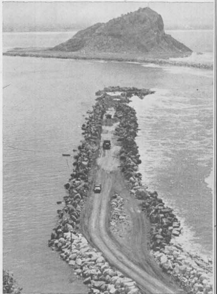
Rompeolas del Crestón totalmente terminado.—Mazatlán, Sin.
