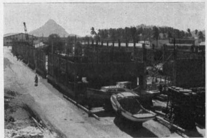
Bodega Fiscal No. 2, en construcción.—Mazatlán, Sin.
