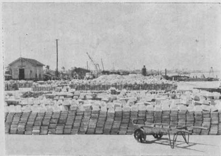
Plomo y Cobre descargado en el Muelle de Metales de Tampico, Tamps.
