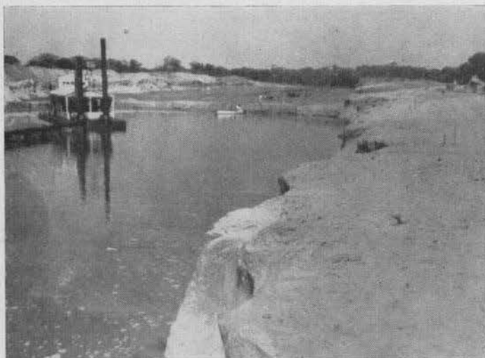
Mejoramiento de la vía fluvial.—Tuxpan, Ver.
