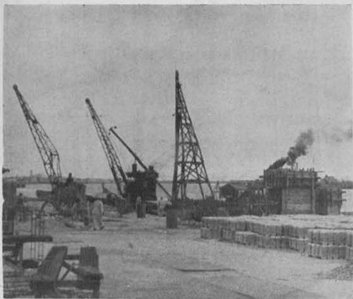
Equipo de Martinete y Grúas que se utilizan en la construcción del segundo tramo del Muelle de Metales y Minerales en Tampico, Tamps., propiedad del Gremio Unido de Alijadores.
