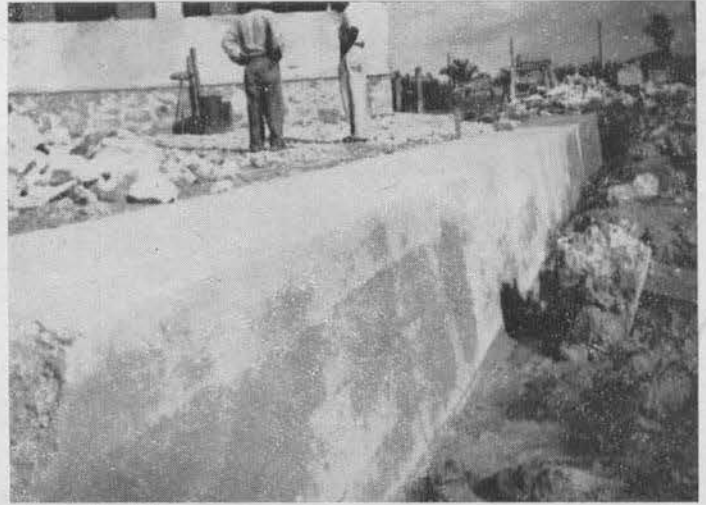
Construcción del muro de protección a la cisterna. Zihuatanejo, Gro.
