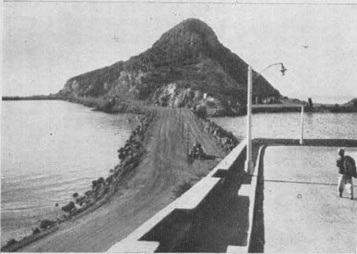
Escollera Azada-Vigía totalmente terminada, con una corona de 15 mts. y una cota de + 5.00 mts.—Mazatlán, Sin.
