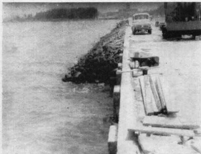
El primer tramo del muelle terminado, con sus losas precoladas ya colocadas. Perfilado del talud Este del espigón y calzada de acceso terminadas.—Antón Lizardo, Ver.
