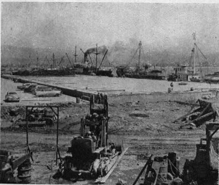
Vista parcial de las obras portuarias en Ensenada, B. C.
