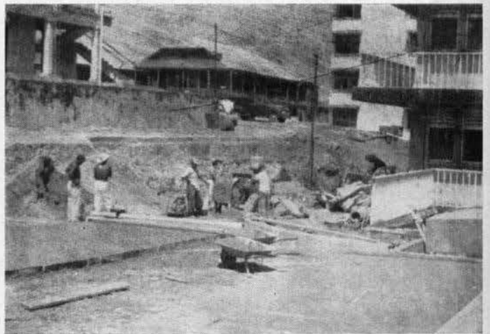
Colado de losas en el patio del almacén.—Coatzacoalcos, Ver.
