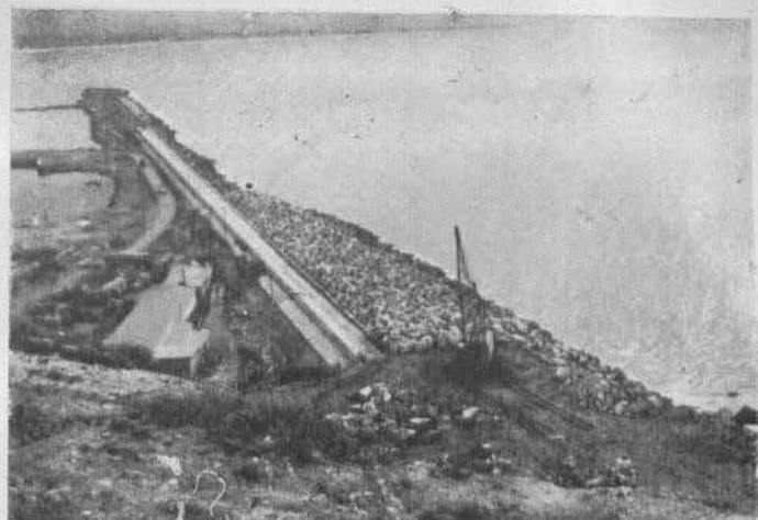
Reforzamiento del Rompeolas. Grúa Clyde terminando el acomodo.—Ensenada, B. C.
