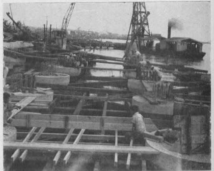
Cimbra segundo tramo del Muelle de Metales.—Tampico, Tamps.
