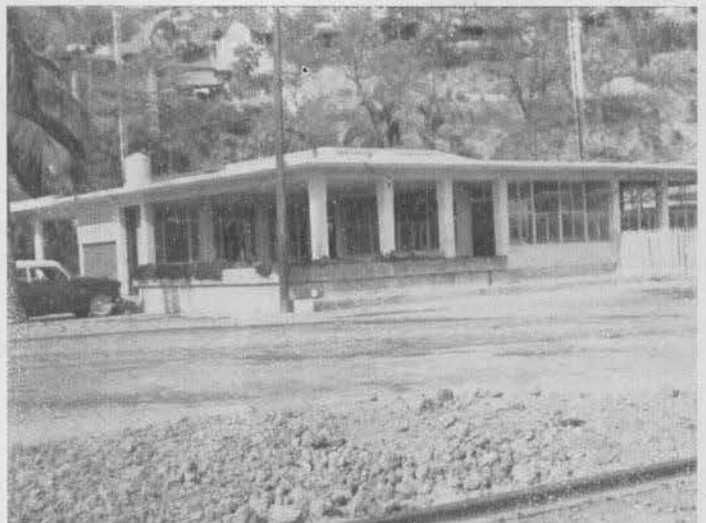
Edificio de las oficinas de la Residencia de las Obras del Puerto de Manzanillo, Col., vista por sus costados norte y oriente.
