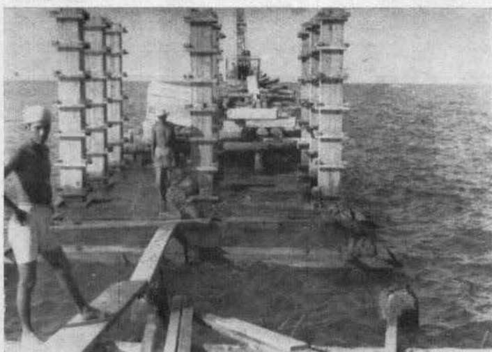
Desmantelando cama para colado de suplementos. Vista parcial de los primeros pilotes suplementarios para aumentar la longitud. De hinca y poder darle mayor calado al muelle.—Antón Lizardo, Ver.
