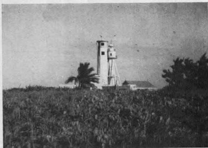
Faro de Cayo Arcas, construido recientemente, en proceso de pintura exterior. Atrás el faro antiguo.—Sonda de Campeche.
