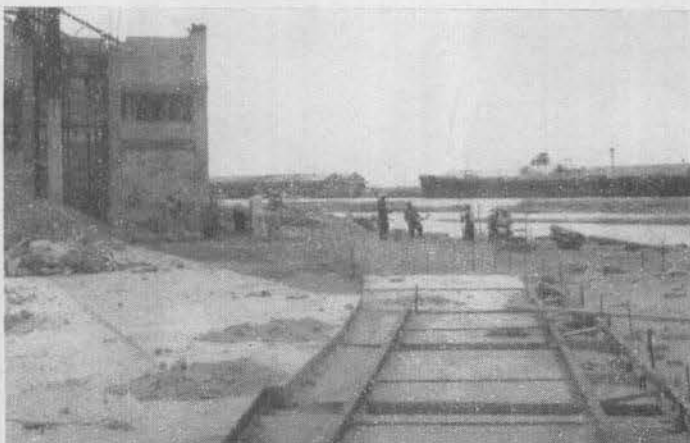
Vías del muelle de reparaciones a flote.—Salina Cruz, Oax.
