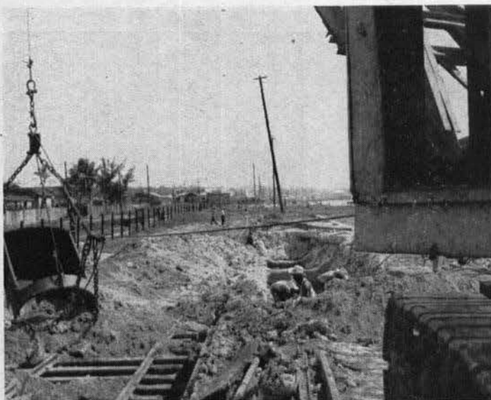
Excavación para el muro-andén en Muelle de Metales.—Tampico, Tamps.
