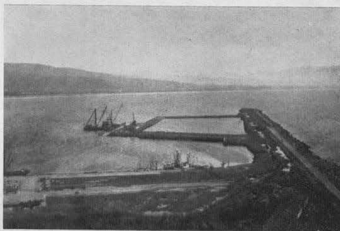
Muelles de Altura.—Nótese en el muro Este el avance de los caminos de ayuda.—Ensenada, B. C.
