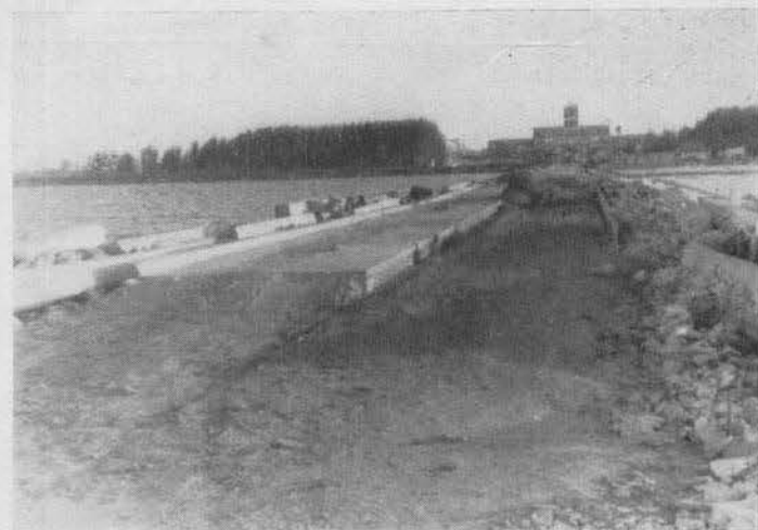
Vista parcial de la calzada de acceso al muelle mostrando el colado de losas y guarniciones de concreto armado sobre la corona del terraplén, ya revestida con una capa de 20 cm de espesor de balasto y otra de 10 cm de arcilla impermeable.—Antón Lizardo, Ver.
