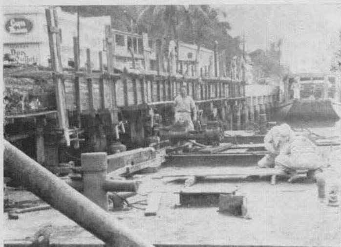
Cimbra para colado de defensa.—Tuxpan, Ver.
