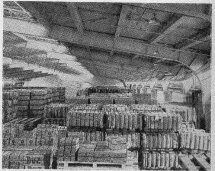
6. Carga almacenada sobre plataformas de carga (pallets) en el interior de una bodega de tránsito. Se tiene una buena iluminación y una gran presencia de comunicaciones con el exterior (a base de cortinas metálicas levadizas). Obsérvese la eliminación total de columnas intermedias. (Puerto de Long Beach).
