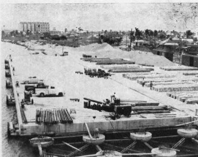
Vista general del primer tramo del muelle de Metales. Tampico, Tamps.
