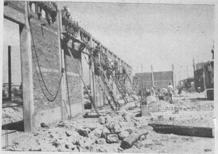
Bodega Fiscal No. 2. Armado de la celosía y trabe de liga. Mazatlán, Sin.
