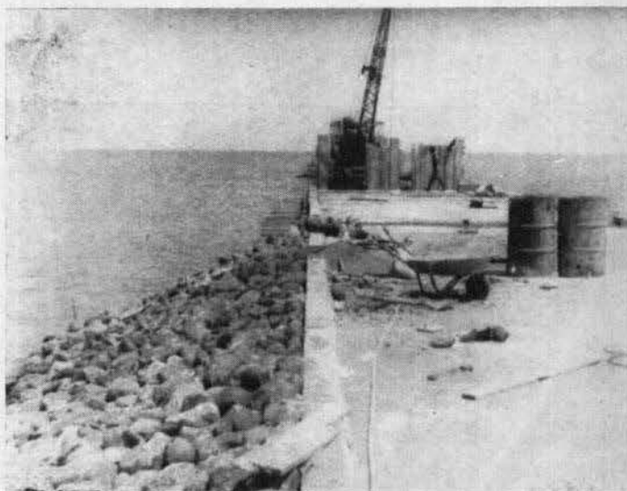
Rehincando los últimos pilotes suplementarios. Vista parcial del primer tramo de muelle terminado mostrando las ménsulas de los cabezales del piso del muelle ya nivelado.—Antón Lizardo, Ver.
