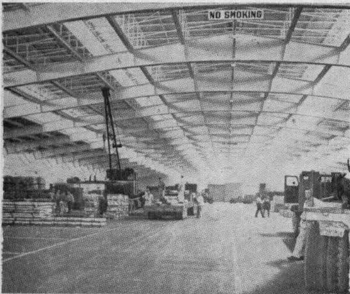
5. Aspecto de una bodega de tránsito. Obsérvese la presencia de vehículos y de una grúa montada sobre neumáticos. La bodega tiene hasta 33' de altura libre en el centro del claro. (Puerto de Long Beach).
