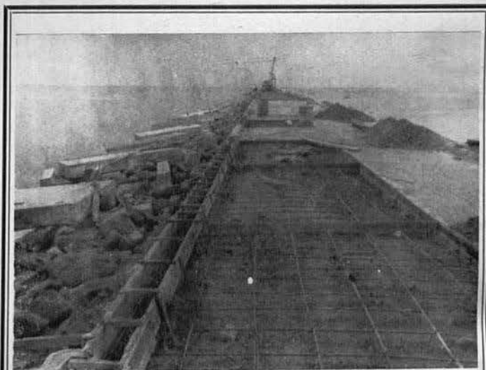
Construcción Muelle en Antón Lizardo, Ver.
