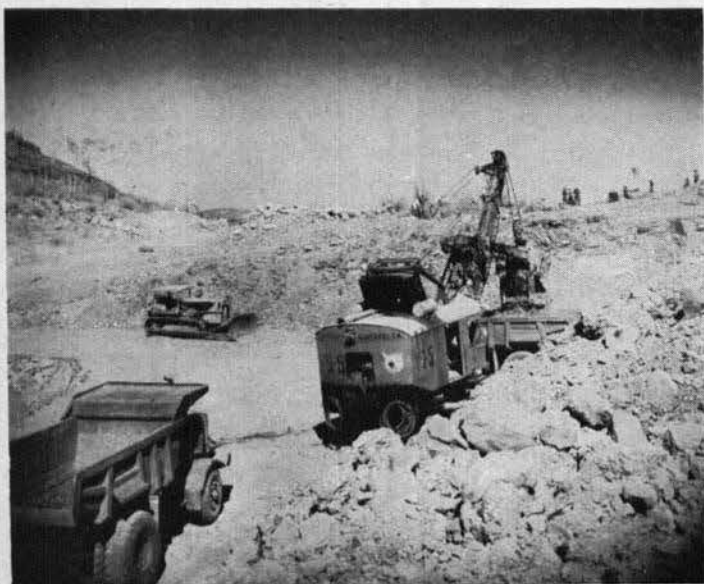
Explotación y carga del material pétreo.
