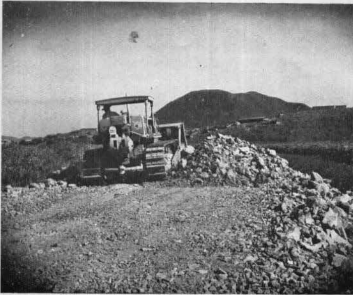
Formación del terraplén del camino.
