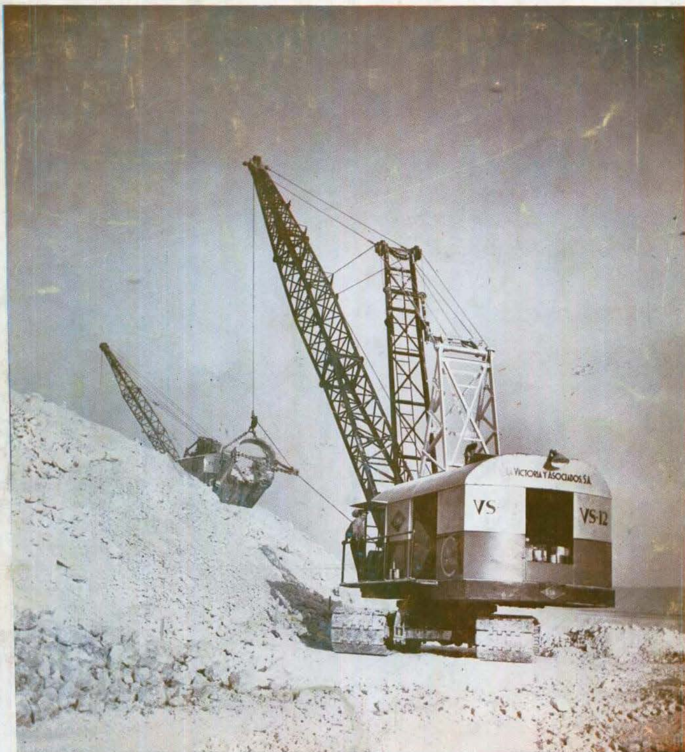
Equipo pesado en la construcción del camino de acceso a Topolobampo, Sin.
