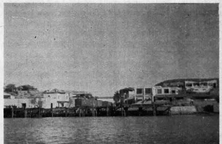
Otro aspecto en vista general del muelle fiscal de este puerto.
