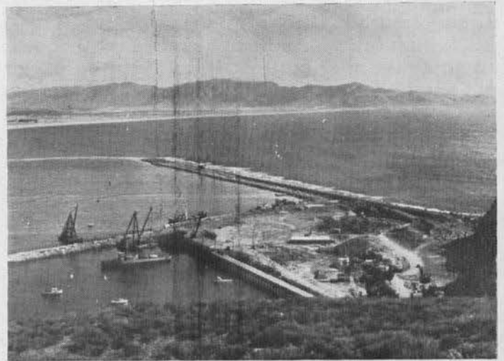
Vista general de las obras en construcción, en Ensenada, B. C.
