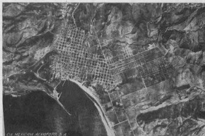
Mosaico de Ensenada, B. C., que muestra las obras del Puerto en proceso de construcción. Diciembre de 1954.
