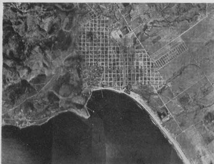
Mosaico de Ensenada, B. C., antes de iniciar las obras del Rompeolas.
