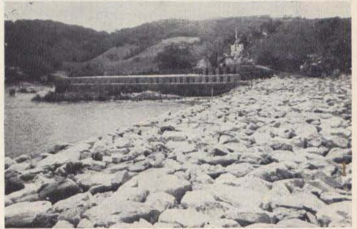
Enrocamiento de acceso para el muelle que se construye en Zihuatanejo. Al fondo se observan los pilotes de concreto.
