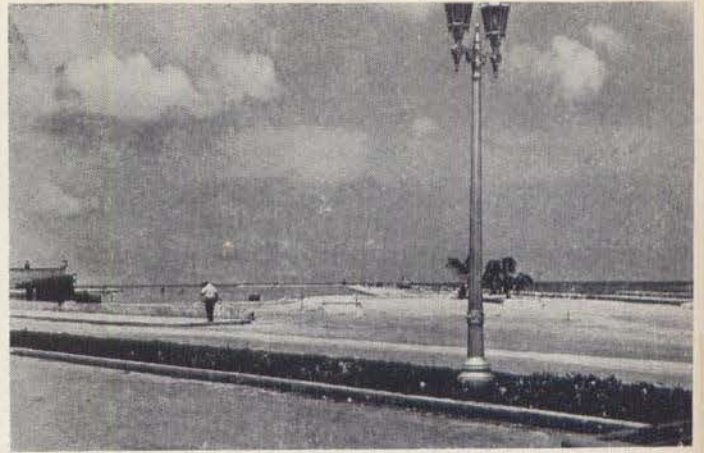
Vista general del Muro de Barlovento (Guadalupe). Obsérvese que ya se está construyendo la curva y al frente hay un tramo ya hecho de banquetta, guarnición y camellón, que da una idea general de cómo se hará la obra.
