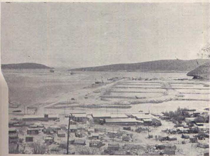
Muelle patio Ardilla. Véase bocana; Draga Mazatlán en Canal Navegación, pared Este en toda su longitud, pared Sur disponible para hinca. Al fondo Varadero Nacional. En primer plano barrio "Punta Arena".
