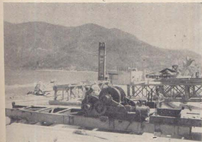
Acapulco, Gro.—La Secretaría de Marina ha dotado de magnífico equipo a sus Residencias de Obras, aquí vemos un Motor Pilo-teadora en Puerto Marqués.
