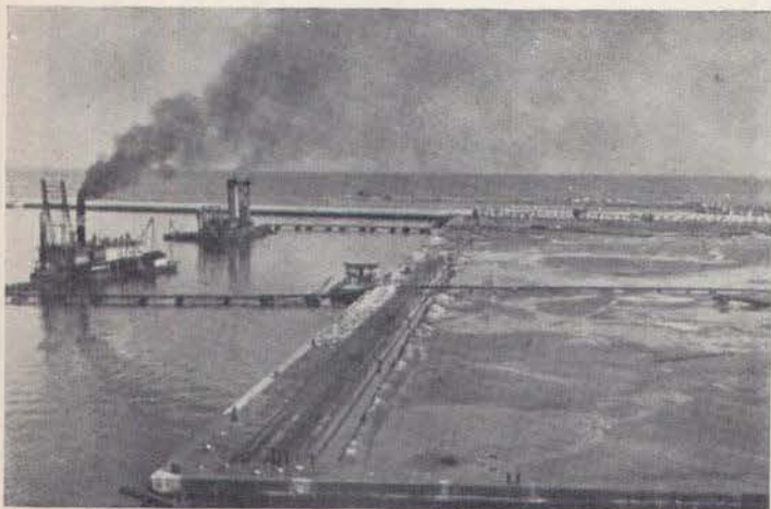
Vista del Muelle Marginal de Veracruz. En primer plano, los rellenos que efectúan actualmente las dragas.
