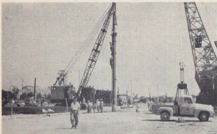
Bodega N° 2. Acomodo de la cachucha en un pilote para proceder a hincarlo.
