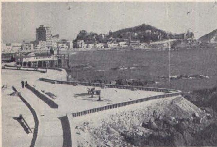
Terraza N° 1 sobre el Paseo Klaussen totalmente terminada.
