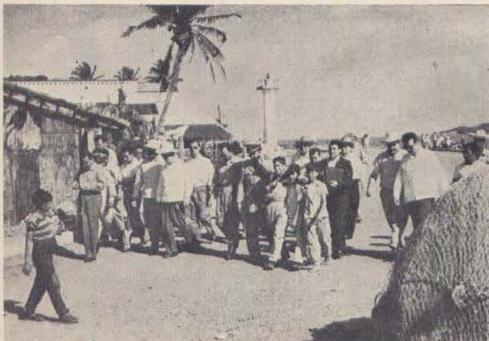
Llega a Alvarado, Ver., para darse cuenta del proceso de las obras.
