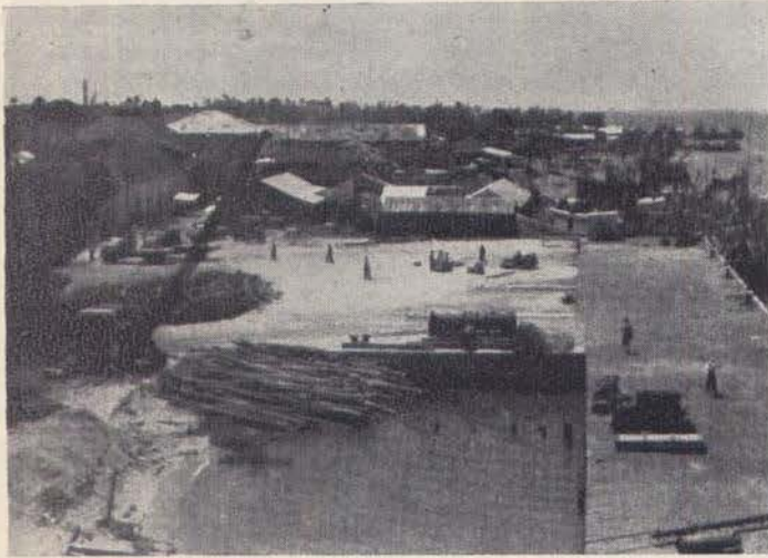
Vista de una parte del tramo de 120 metros del Muelle Fiscal de Ciudad del Carmen, Camp., mostrando al fondo la plataforma de acceso.
