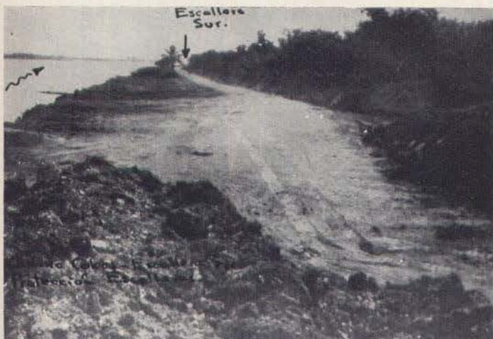
Tramo del camino Cobos a Escollera Sur, construido como obra auxiliar a la protección de dicha Escollera. Tuxpan, Ver.
