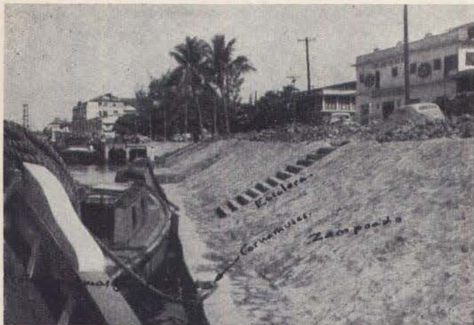
Tramo del Río Pantepec, comprendido entre el Muelle Fiscal y el Atracadero del Chalán, que ha sido protegido mediante la hincada de pilotes, y muros y zampeados que se observan en la fotografía. Tuxpan, Ver.
