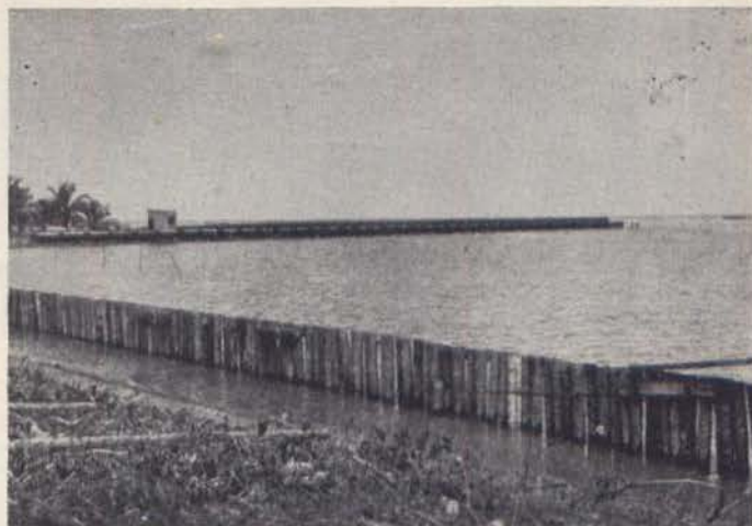
Arranque escollera del "W". En primer término la construcción de la protección de la costa Oeste.
