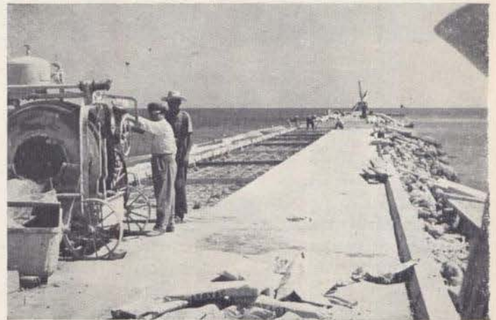
Colado de la cubierta del Muelle de "Antón Lizardo" que se está construyendo en el puerto de Veracruz.
