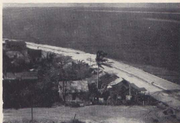
Vista entre las calles de Revolución, Díaz Mirón y Madero, faltando construir muro y banqueta en la margen del río. Al fondo véase la bocana formada por las Escolleras. Bulevar de Coatzacoalcos, Ver.
