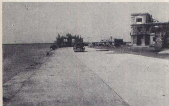
Zona del Malecón ya pavimentada frente a la Capitanía de Puerto y a un costado del Atracadero del Ferry "Papaloapan". Alvarado, Ver.
