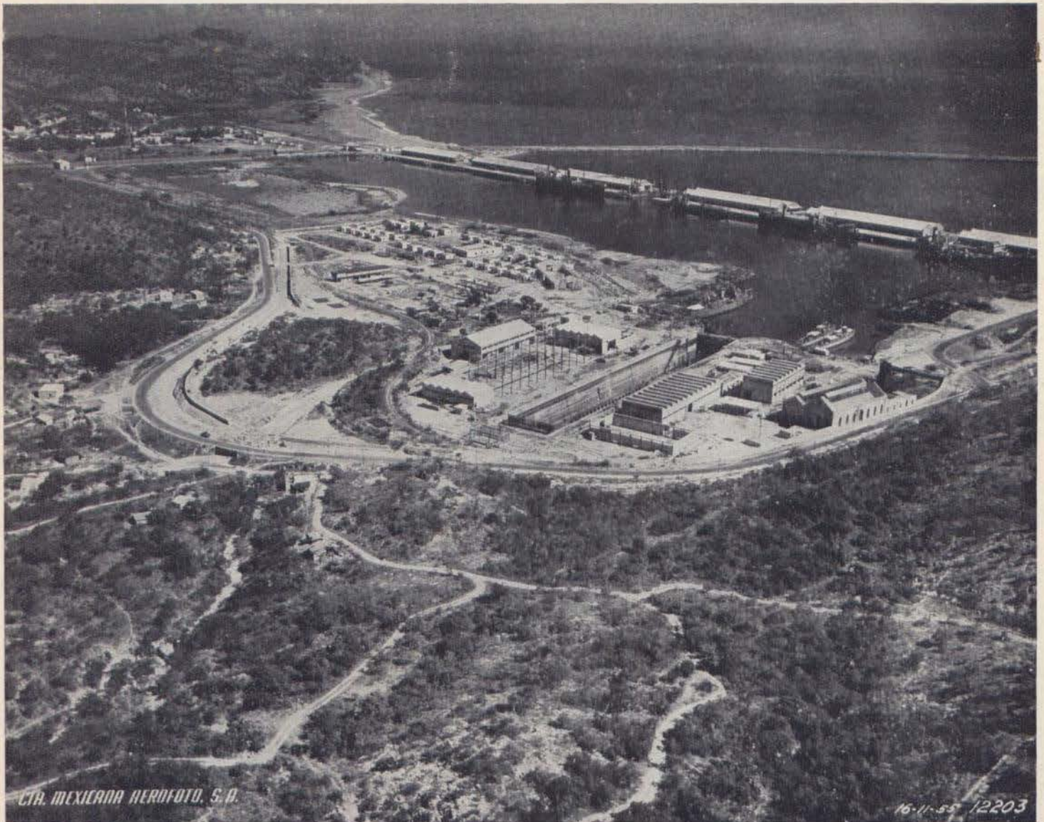
Panorámica aérea del Puerto de Salina Cruz, Oax., mostrando el Dique Seco, las obras auxiliares que se le construyen como Talleres, Almacenes, carretera, vías férreas, etc.; al fondo la dársena y el antepuerto.
