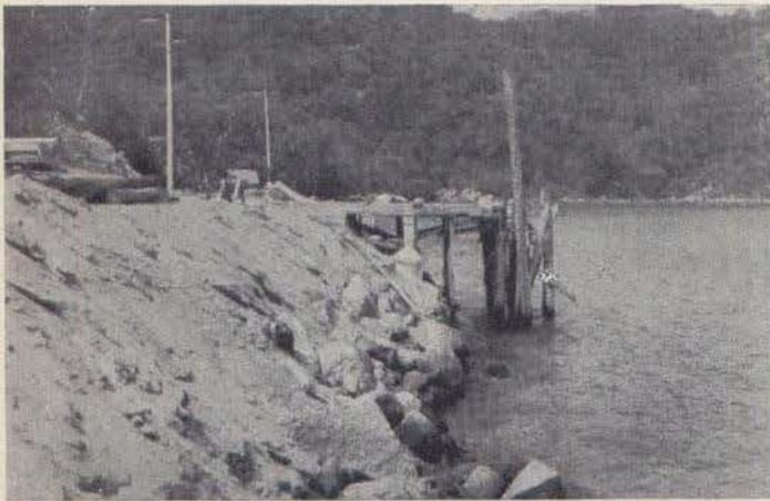
MUELLE DE TURISMO. Vist de Norte a Sur del tramo entre la Caseta Aduanal y el arranque del muelle, donde se arrojaron materiales productos de la excavación, para ganar terreno al mar.
