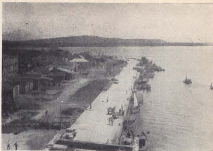
Foto que muestra la primera sección del nuevo Malecón, tomada del Muelle de Cabotaje rumbo aguas abajo. Nótese instalados los arbotantes y bodegas. Alvarado, Ver.
