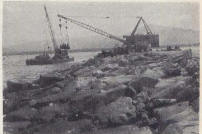
Talud del lado del mar correspondiente a las obras de prolongación del rompeolas de Manzanillo. Equipo de colocación de piedra.
