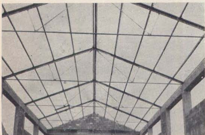
Vista interior del Almacén General, mostrando las armaduras de 2 aguas casi totalmente colocadas.
