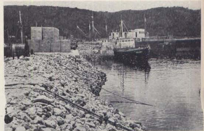
Aspecto del sitio donde se está construyendo un atracadero en el muelle de Lerma. No puede observarse trabajo alguno en virtud de que lo único que se está haciendo a la fecha es acondicionar la cimentación.
