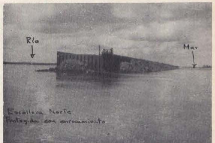
Vista de la protección con enrocamientos de la Escollera Norte del puerto de Tuxpan, Ver.
