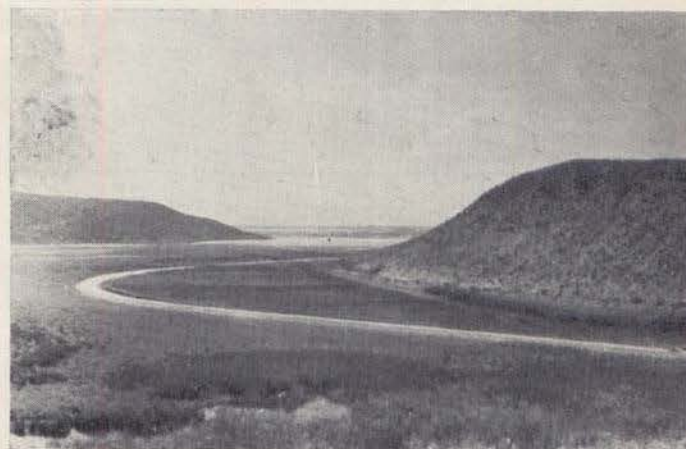
Vista panorámica del camino de acceso a los muelles pasando sobre la marisma y construído de enrocamiento por la Secretaría de Marina en el puerto de Topolobampo.
