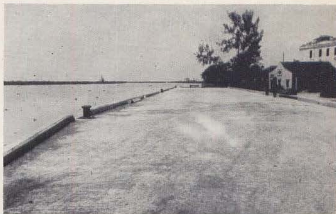
Vista del paño de atraque del muelle de concreto que se construye en Tlacotalpan, Ver.; nótese la guarda, las vitas y cornuzas instaladas.
