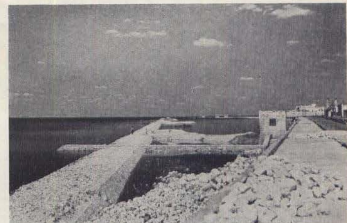
Vista general del Muro de Sotavento. Puede observarse por el interior el recubrimiento de mampostería.
