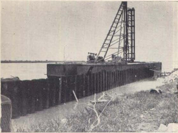
Aspecto general de la obra.
