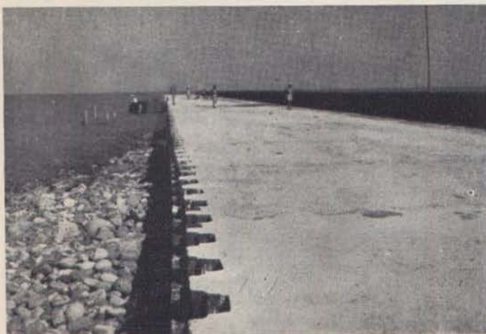
Arranque escollera del "E".
