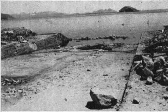
Varadero por reparar
