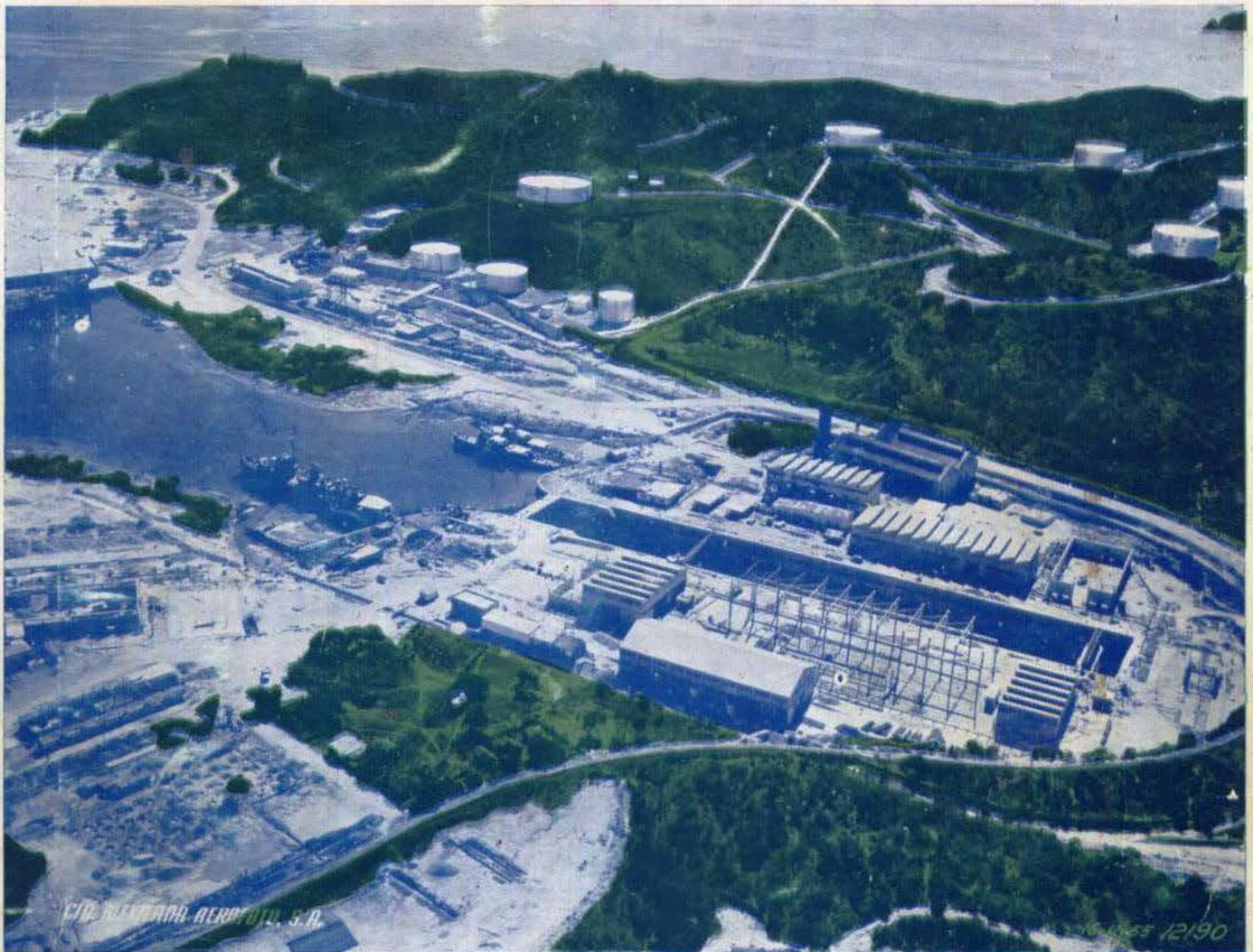
Vista general de las Instalaciones para el funcionamiento del Dique Seco de Salina Cruz, Oax., ejecutadas por la Cía. Constructora "O. M. S. A.", S. A.
