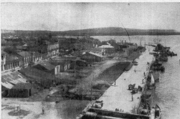
Obras conexas de construcción en Alvarado, Ver.
