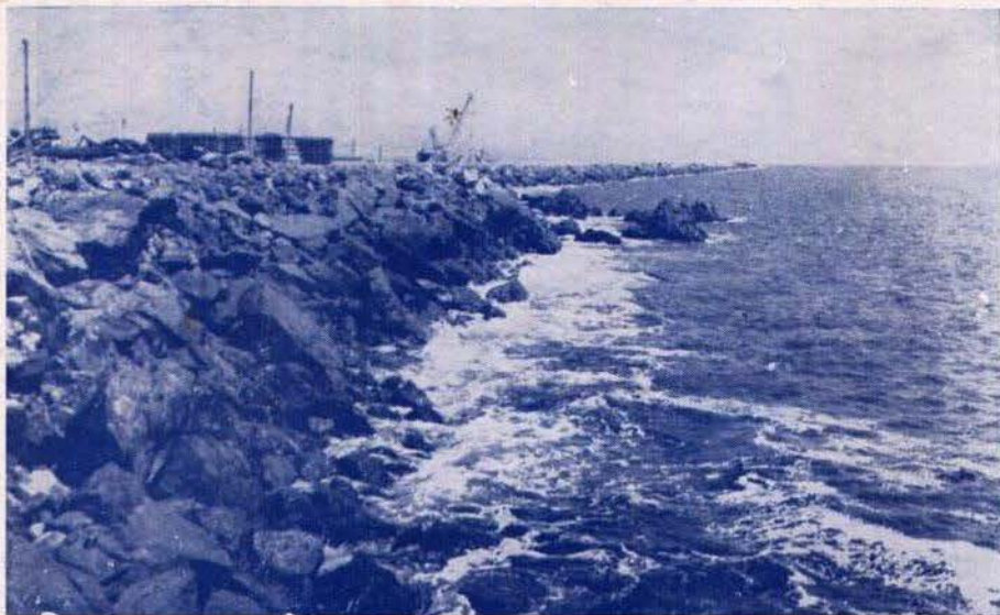
Rompeolas de la Bahía de Todos Santos, Ensenada, B. C. Vista Noroeste, obra que ejecuta la Cía. Chapultepec, S. A.—Ings. Constructores (Antes "CLARK Y MANSILLA, S. A. de C. V.)
