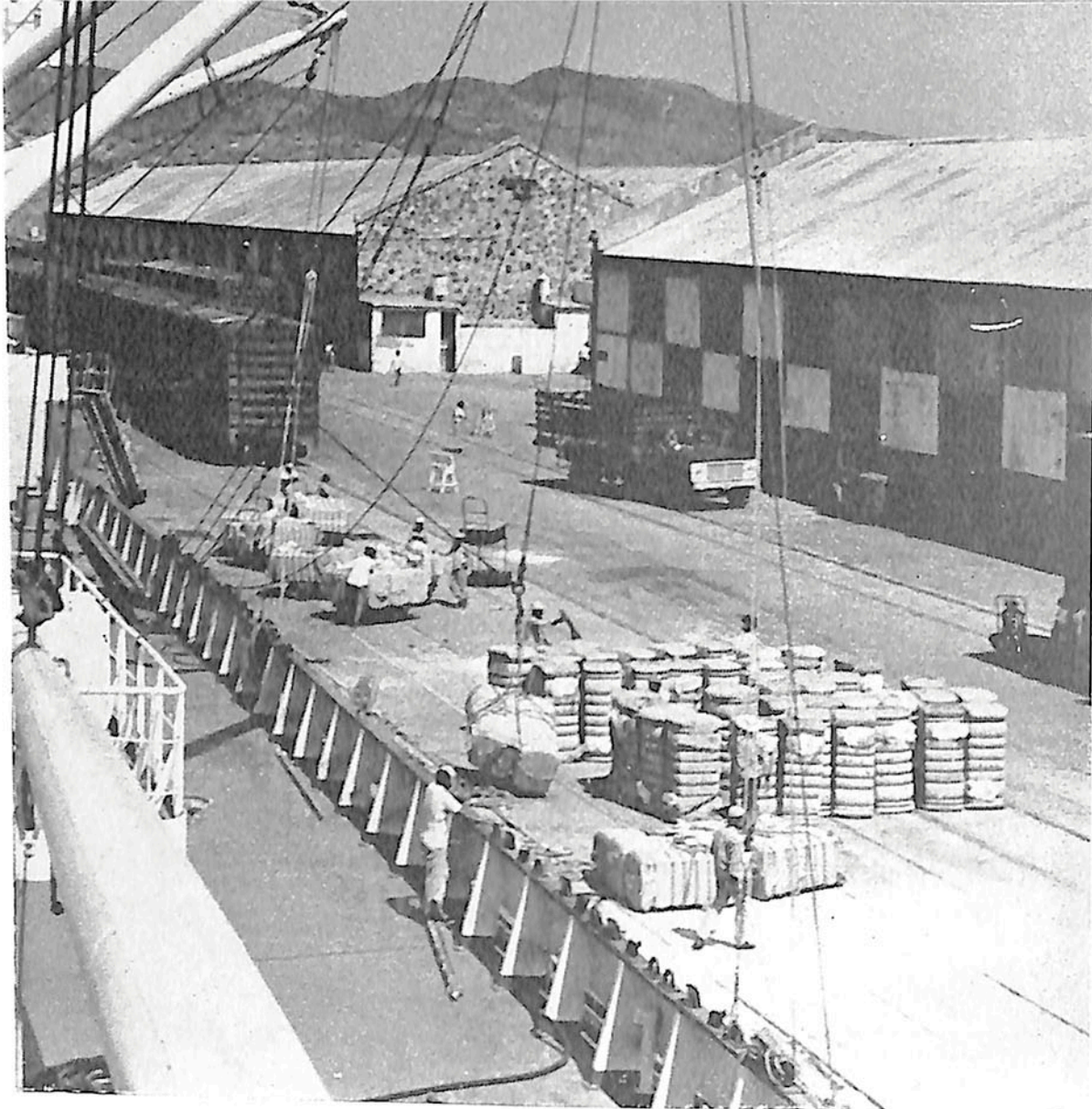
Trabajando en el muelle 2 de zona franca.
