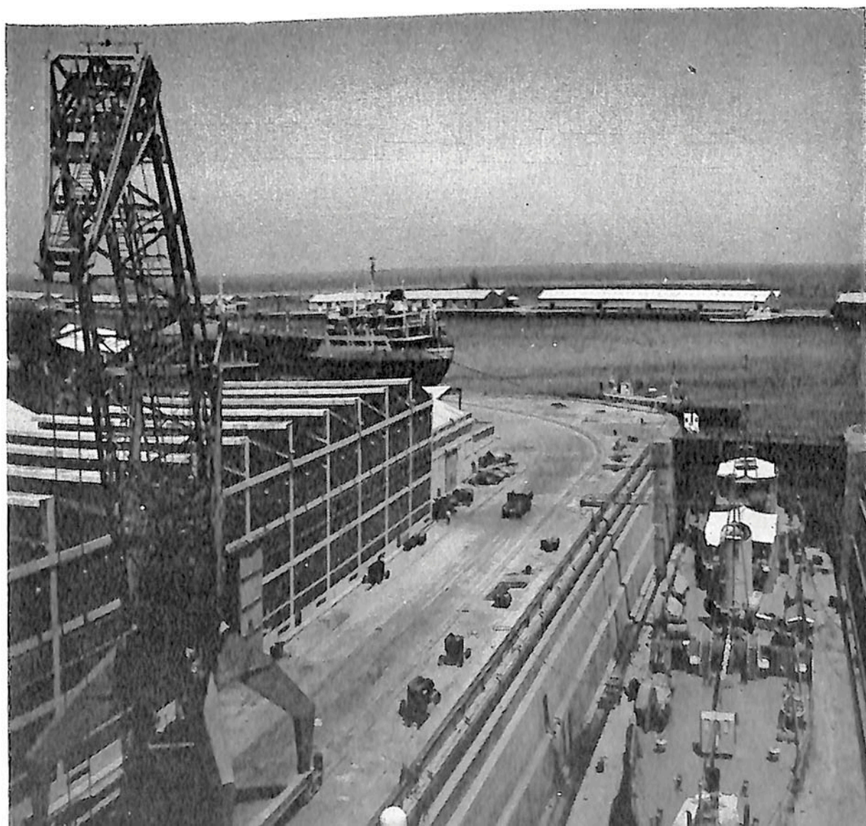
Vista del dique seco.
