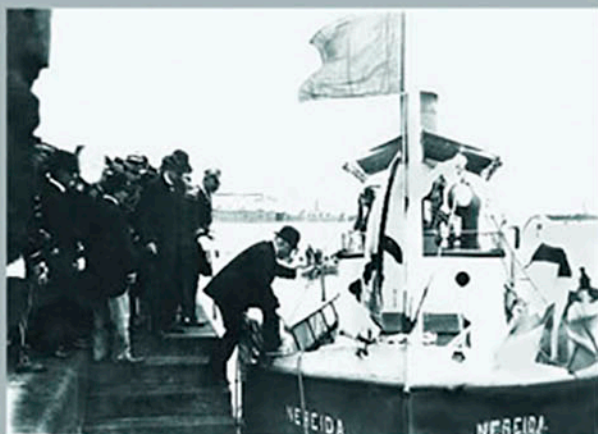
El Presidente de la República Porfirio Díaz aborda el remolcador Nereida durante la inauguración de las obras del puerto de Veracruz, que permitirá la entrada de buques de mayor calado.
