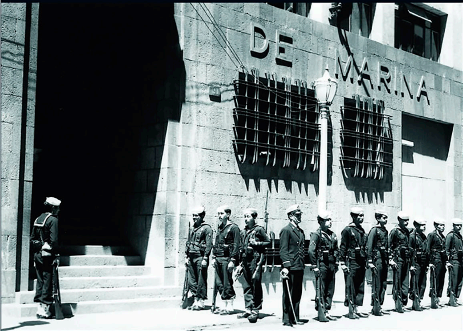
En 1941 fueron establecidas las oficinas de la Secretaría de Marina en la calle de José Azueta en la colonia Centro, D.F., entre Revillagigedo y Balderas.
