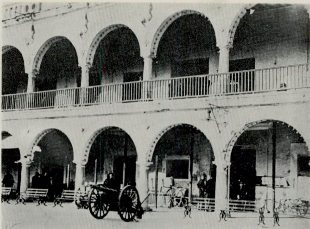
Un cañón de los invasores emplazado en los bajos del Palacio Municipal
