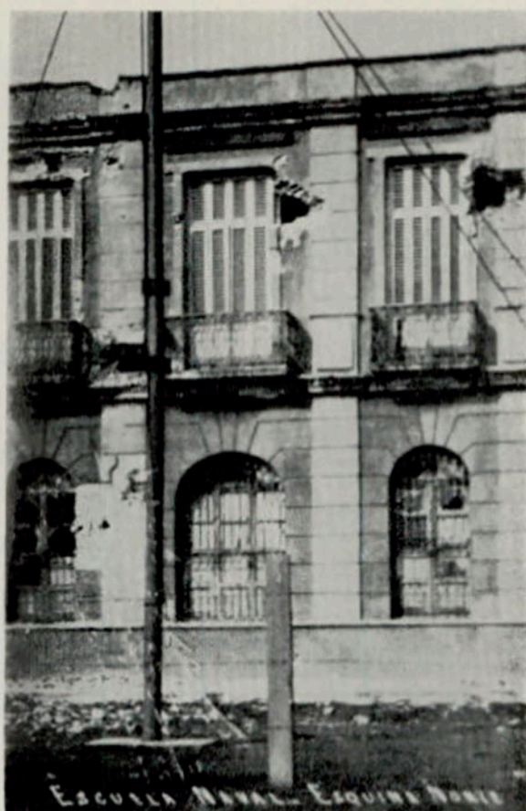
Estado de la esquina norte de la Escuela Naval
