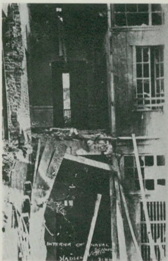
Más vistas del interior de la Escuela Naval
