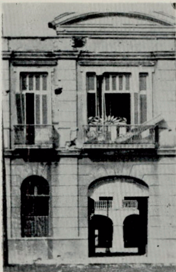
Daños en el frente de la Escuela Naval
