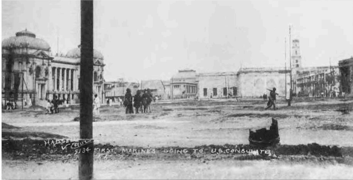
Primeros marinos americanos que se dirigen al consulado de su país. En el centro y al fondo, vemos lo que quedaba del que fuera edificio de la antigua Aduana y que ya estaba siendo demolido.
