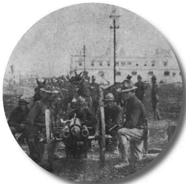
Parte de una batería norteamericana situada delante del edificio de la Dirección General de Faros para defender esa posición.
