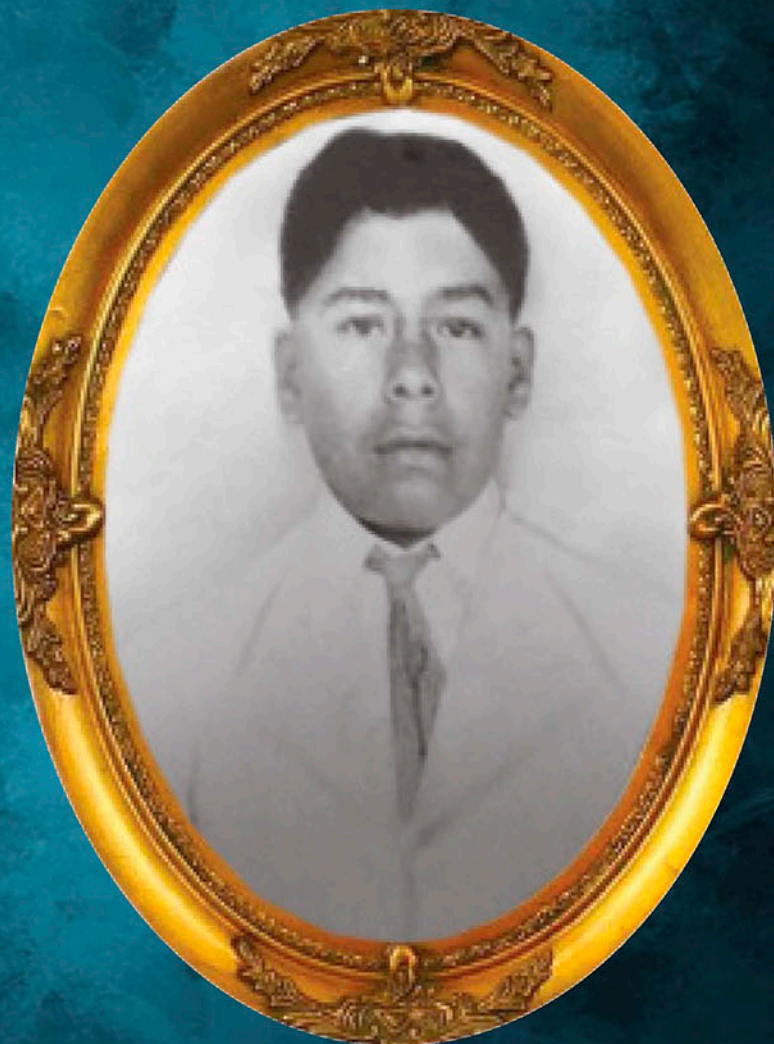
El cadete Eduardo Colina no se movió de su puesto de centinela, a pesar de que una de las paredes donde se encontraba haciendo su guardia se derrumbó, quedando entre los escombros. Hubiera perecido en el lugar, si no le hubieran dado la orden de que abandonara su puesto. Fuente: Archivo General, Secretaría de Marina-Armada de México.
