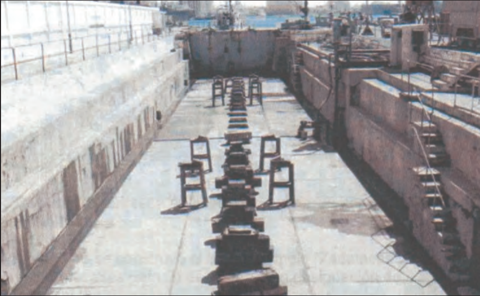
Dique seco de 50 m construido en San Juan de Ulúa.
