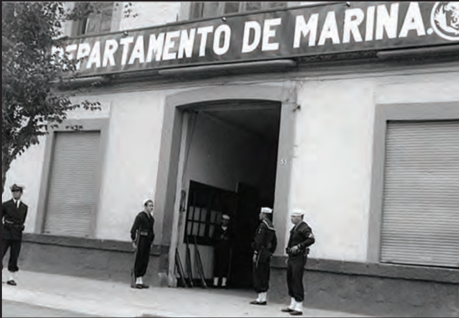
Edificio del Departamento de Marina, ubicado en Balderas Núm. 55, en el centro de la Ciudad de México.
