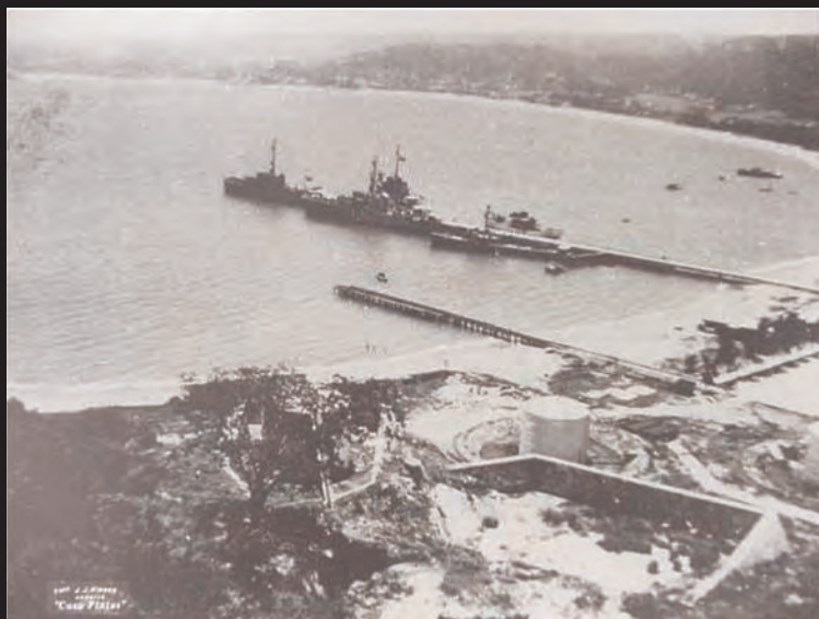
Instalaciones de la Cuarta Zona Naval de Acapulco en 1946, donde se encuentra el Astillero.
