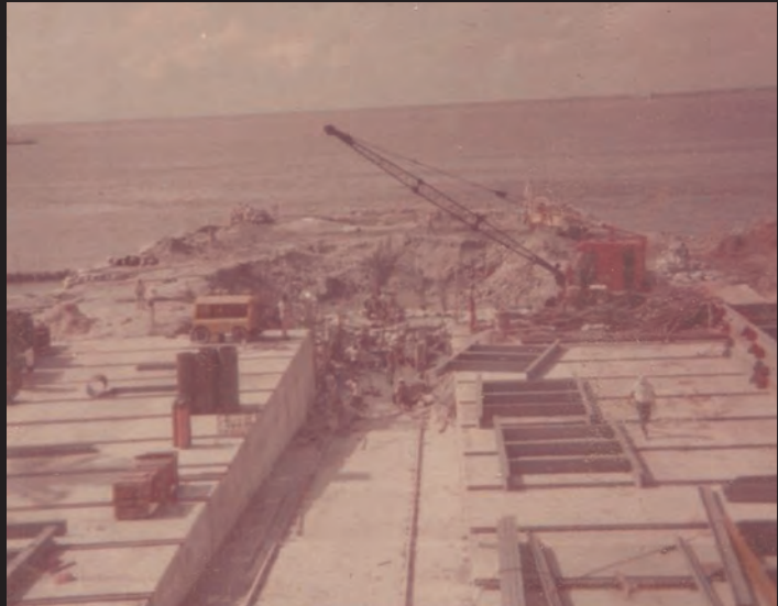
Inicio de la construcción de nuevo varadero 1981.
