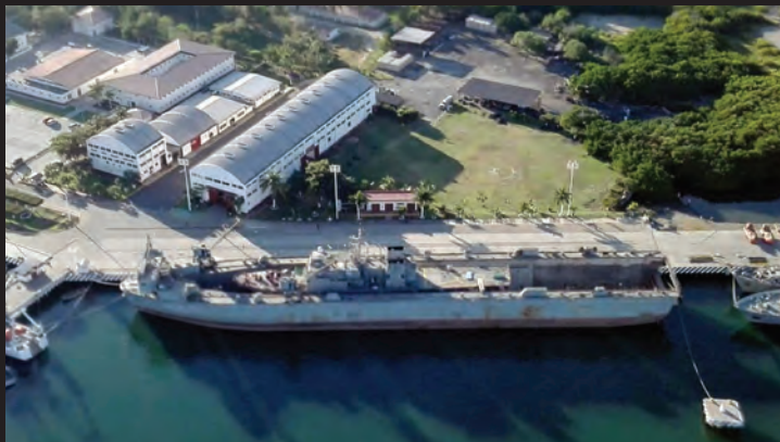
Instalaciones del Centro de Reparaciones Navales, Manzanillo, Colima.
