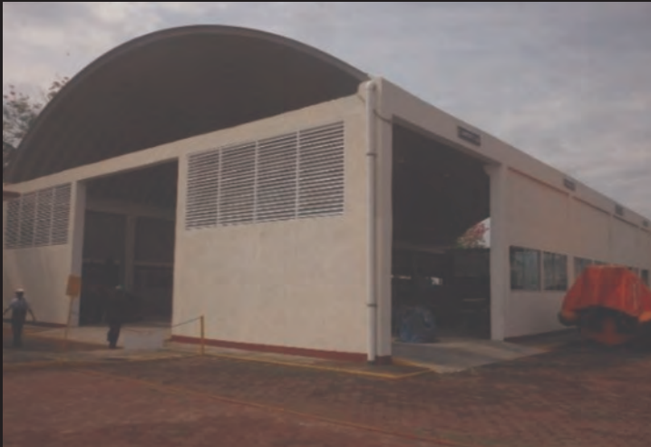
Instalaciones de CENREPFRONT-5.
