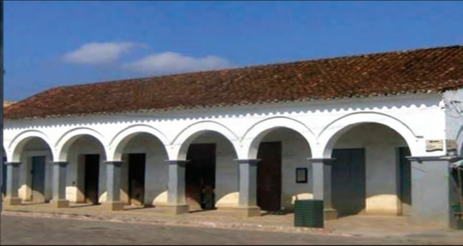
Fotografía actual de la sede del Colegio de Marina de Tlacotalpan.
