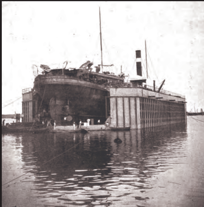
Dique flotante reparando a la draga México.
