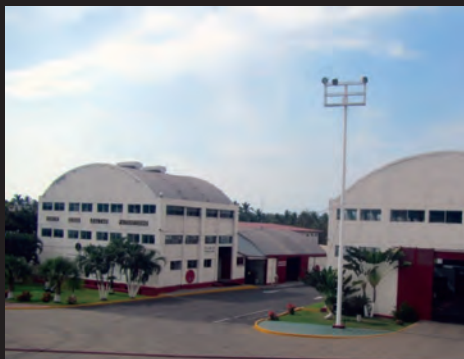
Vista frontal de las instalaciones del Centro de Reparaciones Navales, Manzanillo, Colima.
