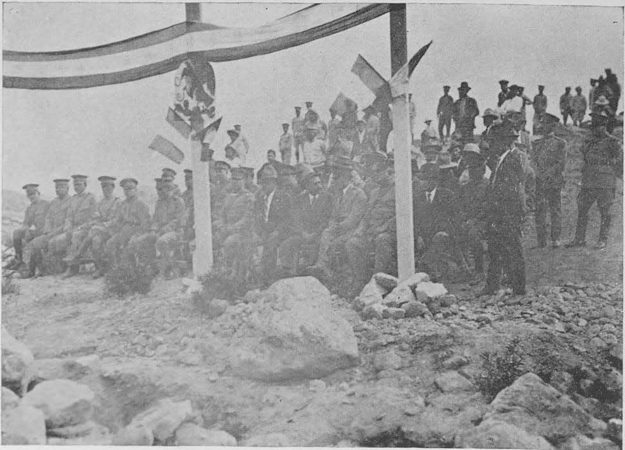
Concurrentes a la ceremonia con motivo de la colocación de la primera piedra para la construcción del "Puente del Ejército," sobre el Chamizal.
