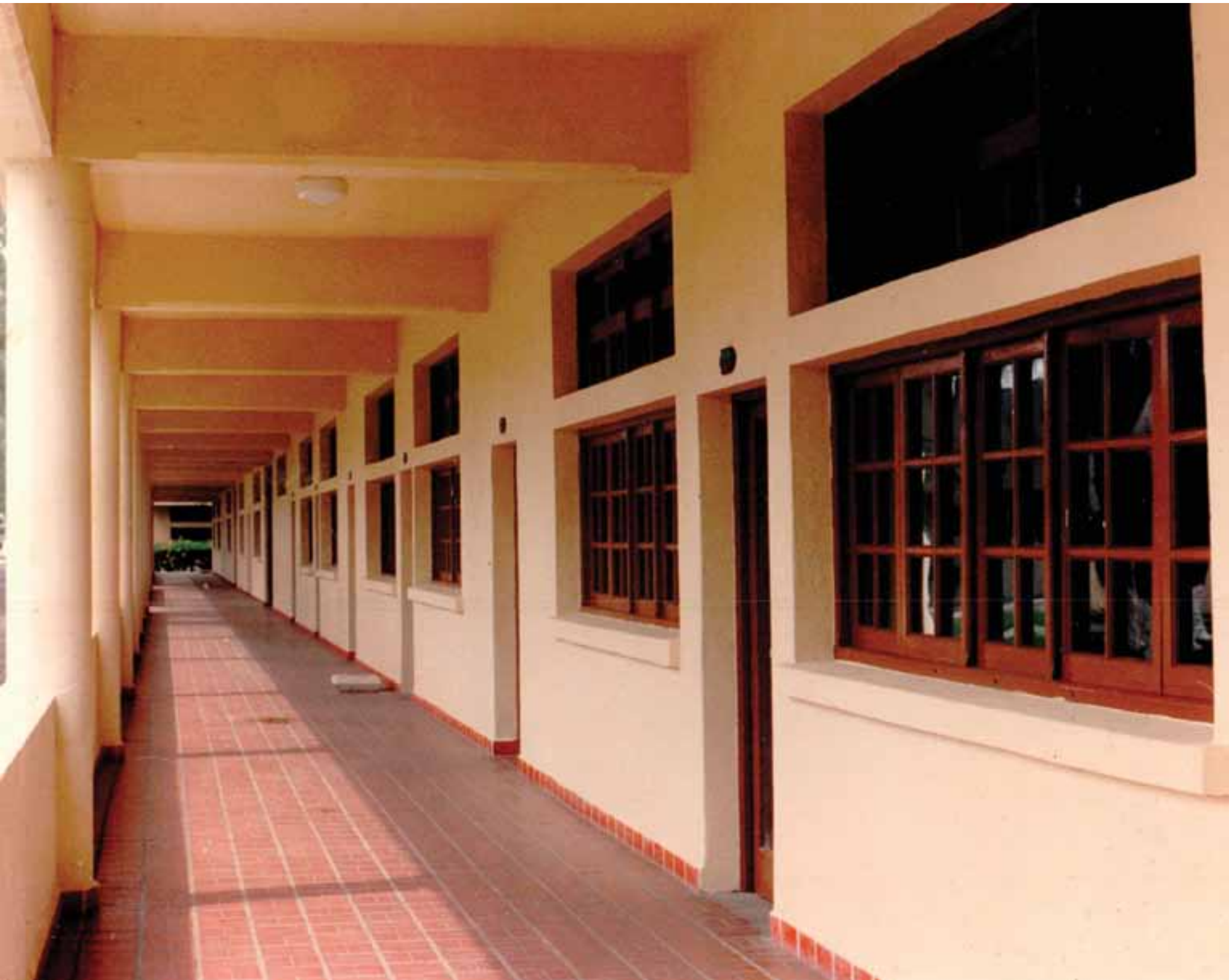
Pasillo del edificio de salones de la Heroica Escuela Naval Militar.
