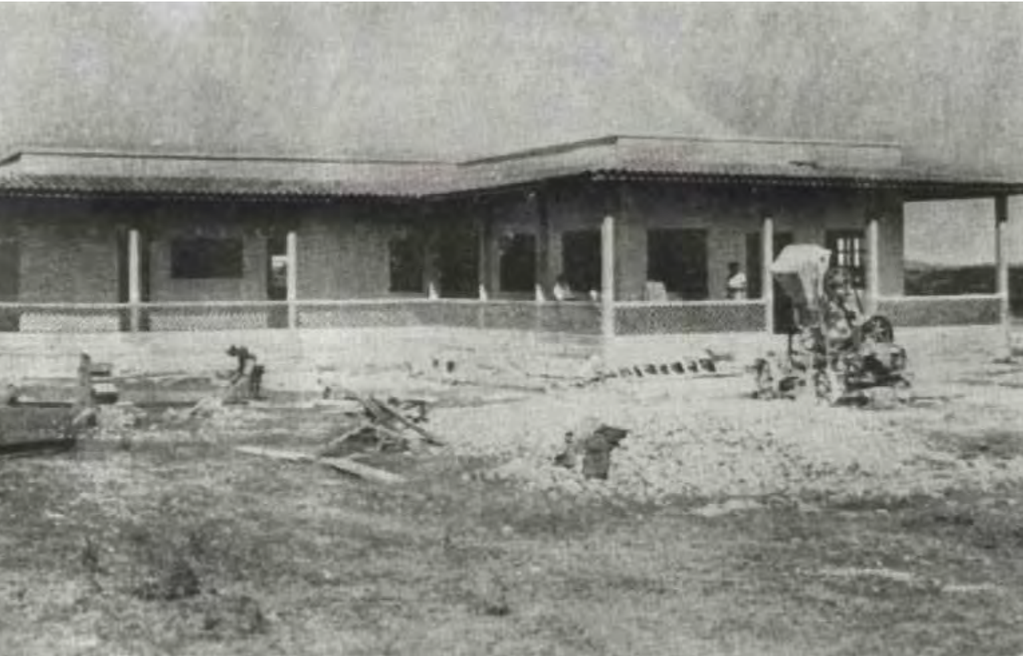
Construcción de la enfermería de la Escuela Naval Militar del Pacífico. Memoria de Marina, 1944-1945.
