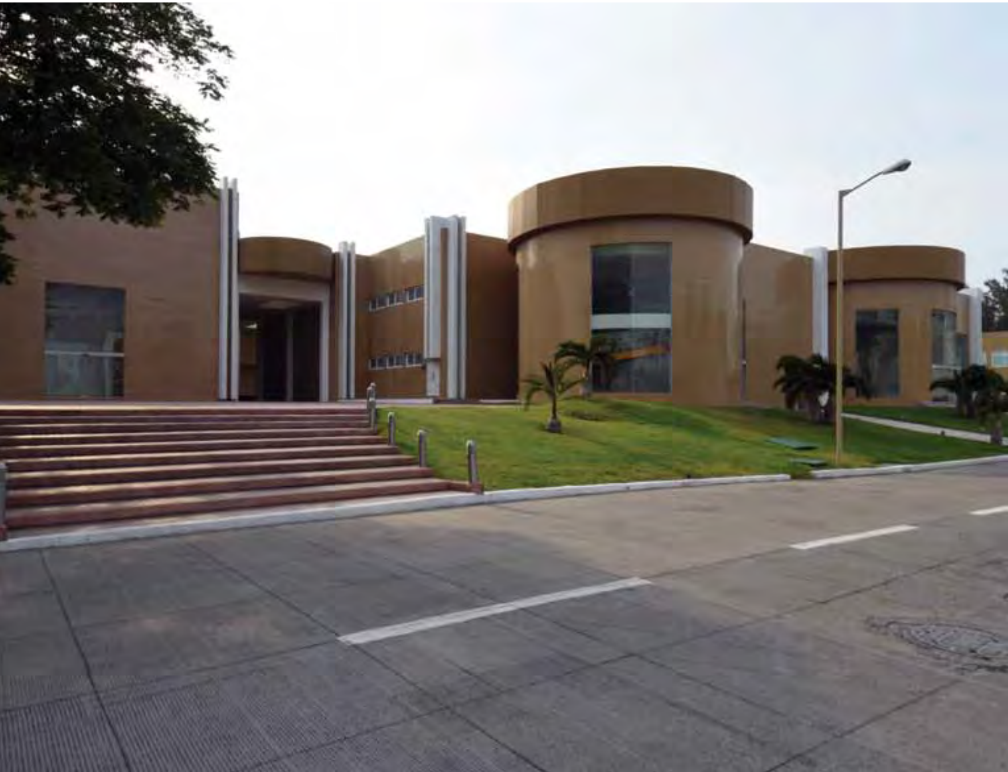
Fachada actual del Gimnasio.
