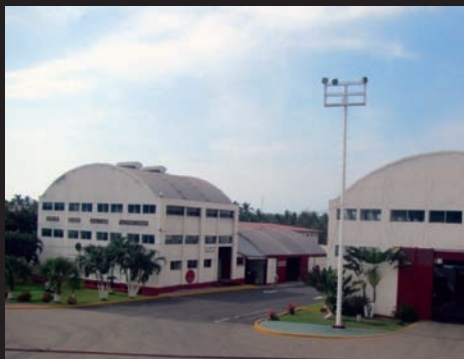
Vista frontal de las instalaciones del Centro de Reparaciones Navales, Manzanillo, Colima.
