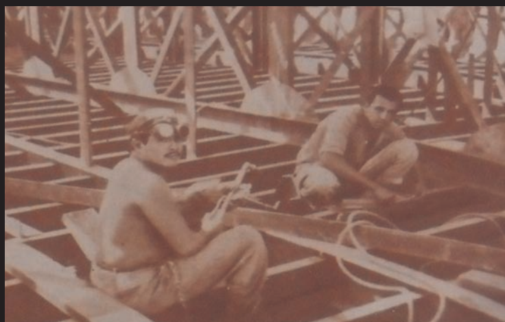
Construcción de un ferry en el Astillero Número 1 de Marina en Tampico, Tamaulipas.
