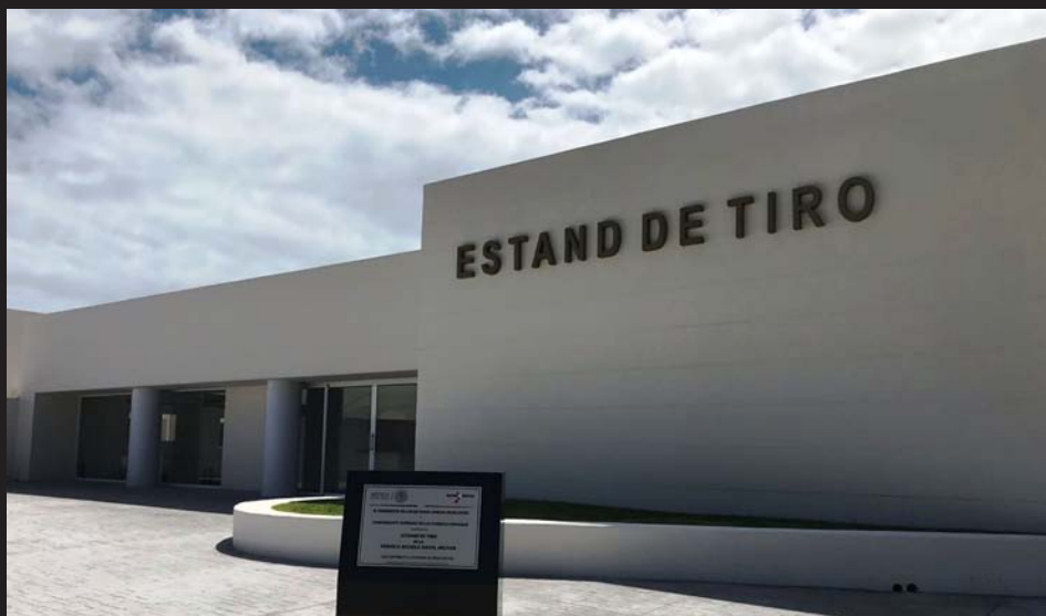
Fachada del edificio del Estand de Tiro.
