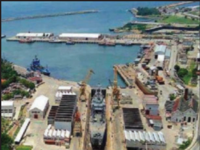
En las instalaciones del Astillero de Marina en Coatzacoalcos se llevó a cabo la construcción de las patrullas interceptoras Polaris II.
