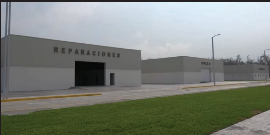
Taller de reparaciones y Estación de buceo.
