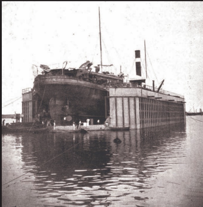
Dique flotante reparando a la draga México.
