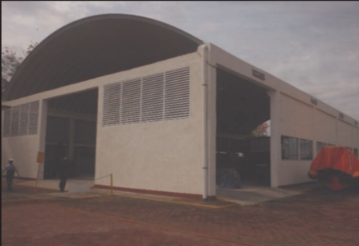
Instalaciones de CENREPFRONT-5.
