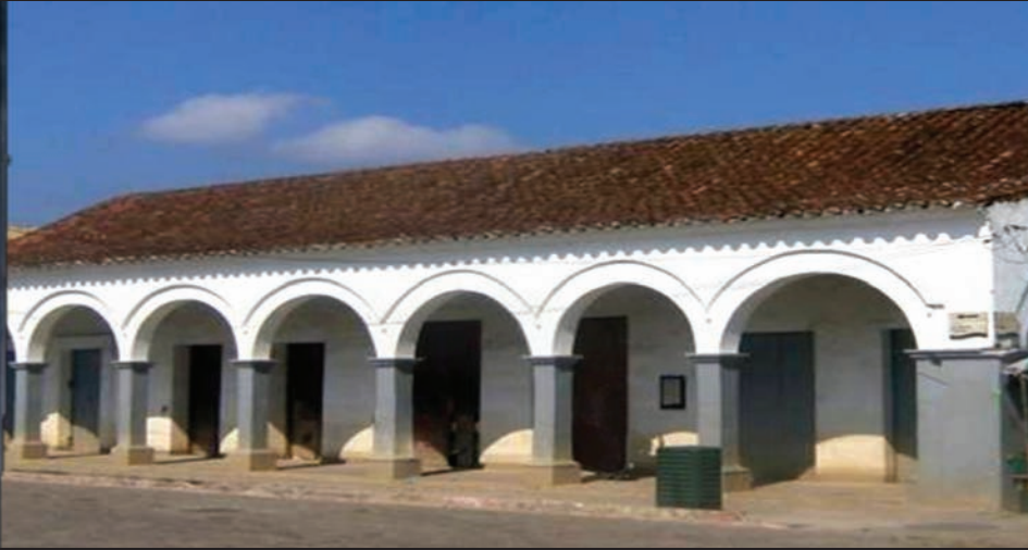
Fotografía actual de la sede del Colegio de Marina de Tlacotalpan.
