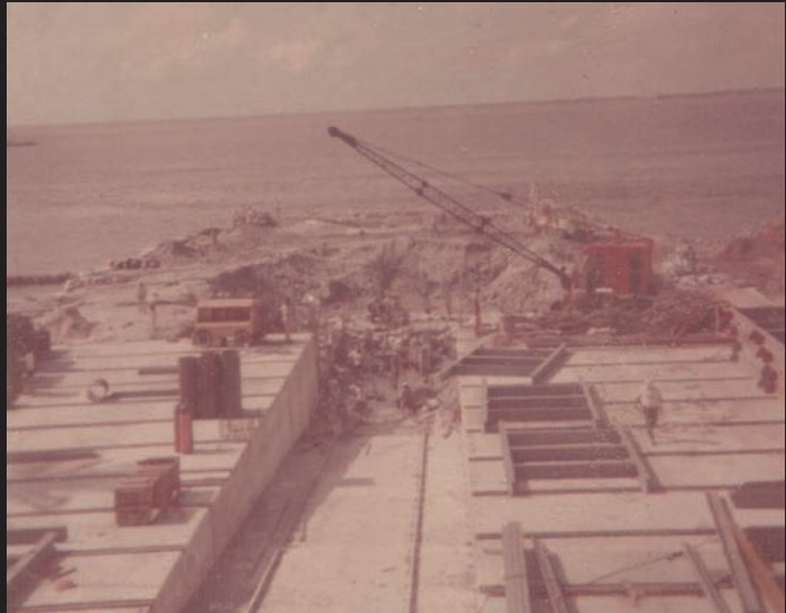
Inicio de la construcción de nuevo varadero 1981.
