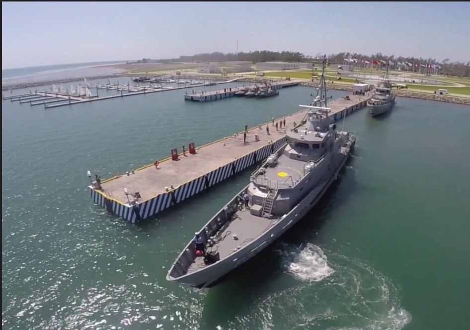
Vista aérea del muelle fijo.
