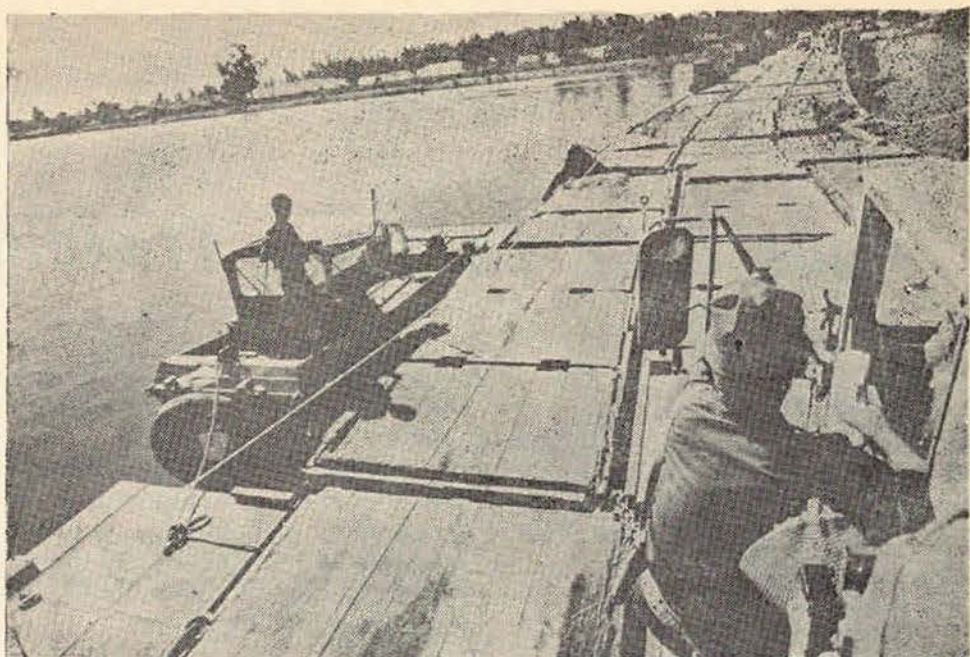
Vista de uno de los dos puentes de pontones y barcazas construidos por los israelíes para cruzar el Canal de Suez. Muchos de sus elementos han quedado a la deriva o semihundidos haciendo más difícil la labor de limpieza del Canal.
