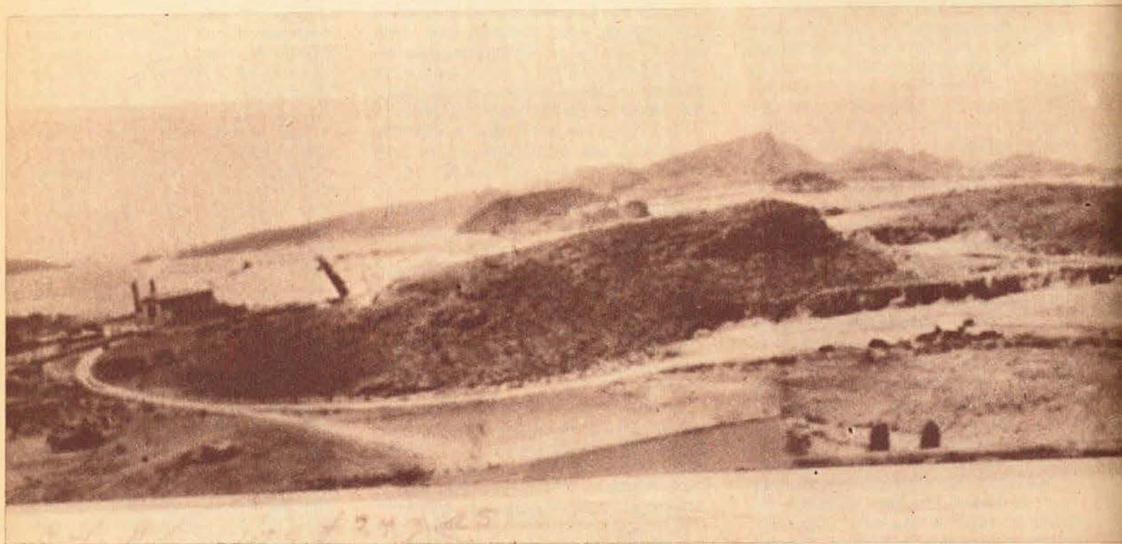
Frente de explotación en MONTE COLITA para material de relleno del MUELLE PATIO. En la parte superior izquierda puede verse el muelle en construcción.
