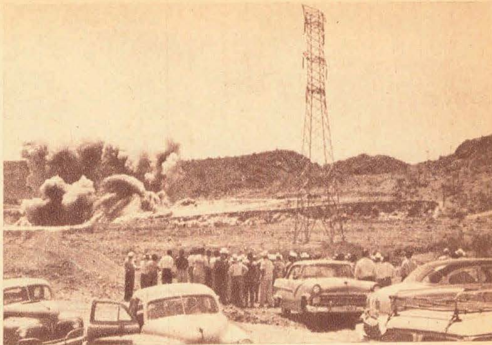
Una "tronada" en el frente de explotación en MONTE LOLITA, para extraer material de relleno.
