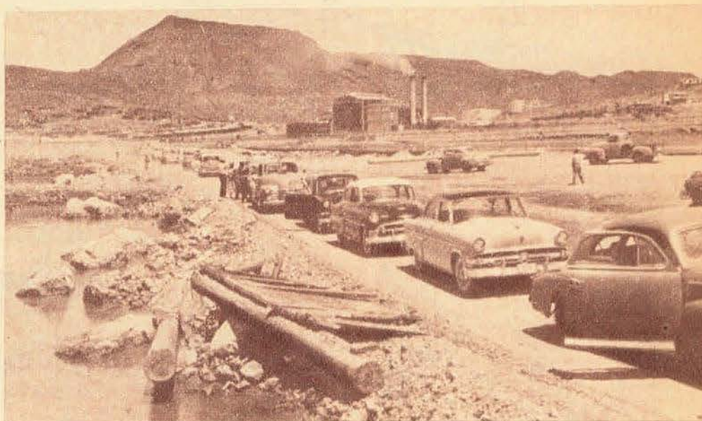
Hincamiento del primer pilote exterior de la banda del MUELLE PATIO. Los vehículos en terrenos ganados al mar.
