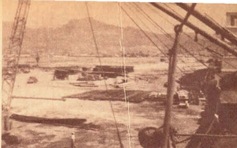
Vista general de la descarga de tablaestaca y azúcar.
